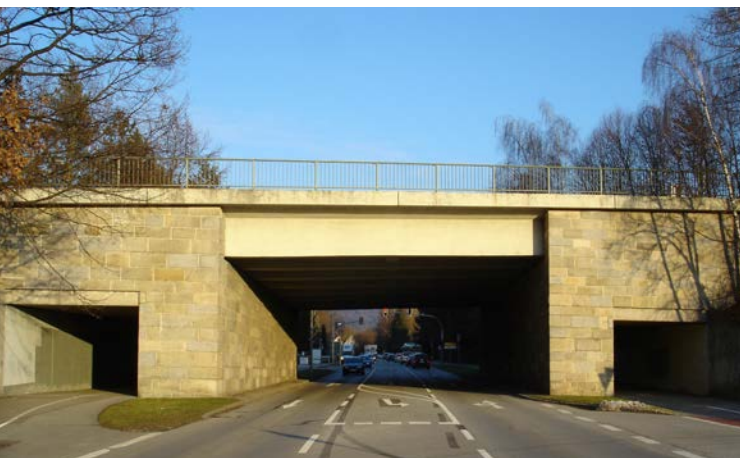
Die 1939 errichtete Ruselstraßenunterführung. Die Durchbrüche links und rechts stammen aus den 1970er Jahren. (Foto: Alois Wanninger)
