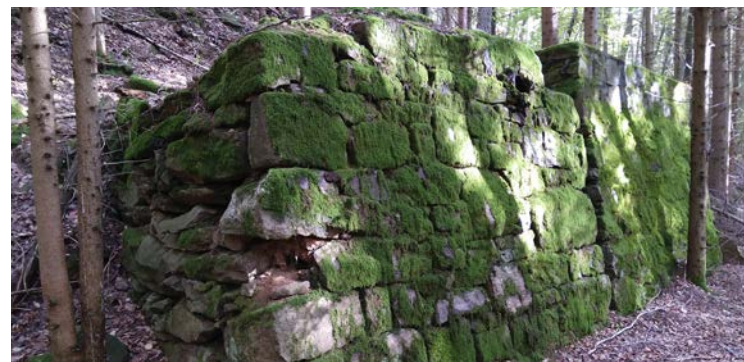
Probemauer mit zwei unterschiedlichen Bauweisen für die Hangsicherung (Foto: Florian Jung)
