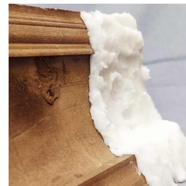
Auftrag der Gelkompressen auf ein Profil – die Masse passt sich den Unebenheiten an und haftet auch an den Senkrechten (Foto links: BLfD, Elisabeth Frick; alle anderen: BLfD, Julian Schmid)
