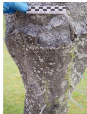
Vorher und nachher: Risse und Schalen wurden mit mineralischer Zementsuspension verfüllt ....
