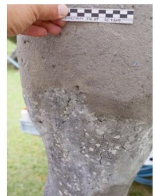
... und freiliegende Bewehrung und Ausbrüche mit Betonersatzmörtel überdeckt.
