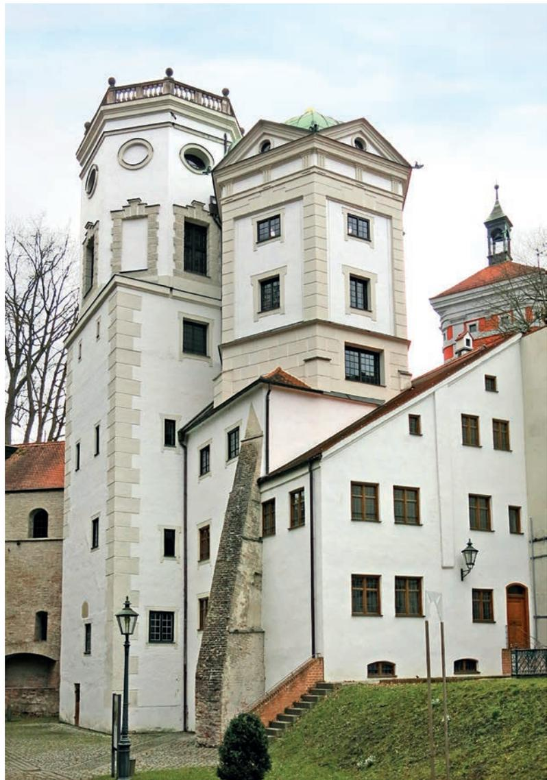
Augsburg, Wasserwerk am Roten Tor. Großer Wasserturm, ursprünglich ein Wehrturm der Stadtbefestigung, seit 1416 als Wasserturm genutzt; Kleiner Wasserturm 1470 gebaut; beide mehrfach aufgestockt, um die Mitte des 18. Jahrhunderts Einbau des seinerzeit berühmten Pumpensystems (Foto: BLfD, Harald Gieß, 2018)
