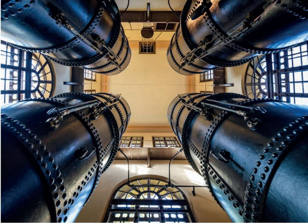
Augsburg, Wasserwerk am Hochablass, 1878/79. Vier Druckwindkessel im Nordturm (Foto: Stadt Augsburg, Martin Augsburg, 2019)
