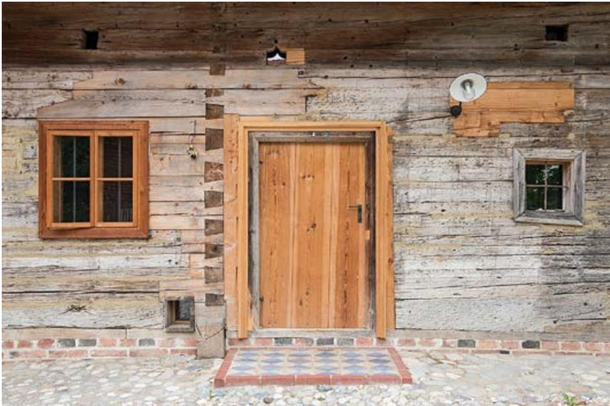
Graming, Lkr. Altötting, Lichtmayrgütl, Ausschnitt aus der traufseitigen Südfassade im Vorzustand (oben) und nach Instandsetzung der Schäden am Holzblock und mit außenliegender Aufdopplung auf dem bauzeitlichen Türblatt. Oberhalb des Türsturzes bauzeitliche Einflugsöffnung des dahinterliegenden Taubenkastens, ebenso linkerhand der Türe Geflügelzugang in die Stube (Fotos: BLfD, Paul Huber, Michael Forstner)
