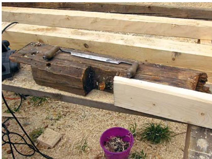
Zimmermannsmäßige Ergänzung an der originalen Stuhlsäule der Dachkonstruktion (1538d) (Foto: Harald Bader)
