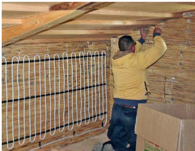
Graming, Lkr. Altötting, Lichtmayrgütl, die vorgefertigten Schilfrohmatten als innenliegende Dämmschicht sowie die Heizschleifen werden vor Auftrag des Lehmputzes angebracht (Fotos: Harald Bader)
