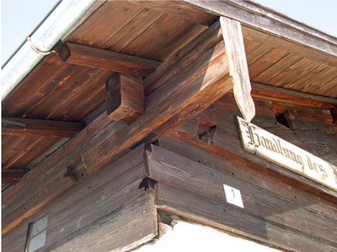
Rahmenkonstruktion des Dachs von 1557, Südostecke, mit Zapfenloch des fehlenden Eckständers und Blattsitze der Kopfbänder; unter dem Balkenrahmen Verbretterung des ursprünglich offenen Zwischenraums über der Stube (Foto: Architekturbüro Naumann)
