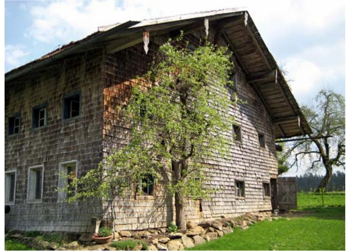
Abb. 16. Oberried, Gde. Drachselsried, Dorfstr. 16 (Lkr. Regen). Unter der Verschindelung kann in diesem Fall eine Dämmschicht installiert werden (Foto: BLfD, Julia Ludwar)
