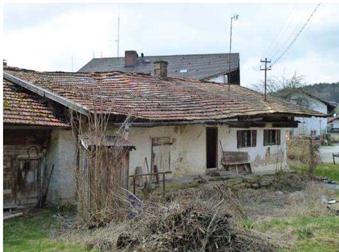
Die Traufseite im Vorzustand. Erkennbar sind die auf schwere statische Schäden zurückgehenden Verformungen der Dachfläche (Foto: BLfD, Bernd Vollmar)
