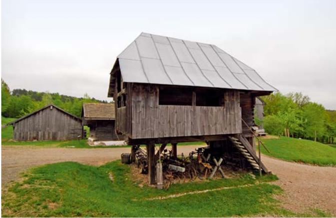
Abb. 12. „Kolbeck-Hof“, Kasten von 1812, damals noch mit Schindeldach versehen. Oft wechselte man diese Deckung später wie hier durch Blech aus (Foto: Georg Waldemer)
