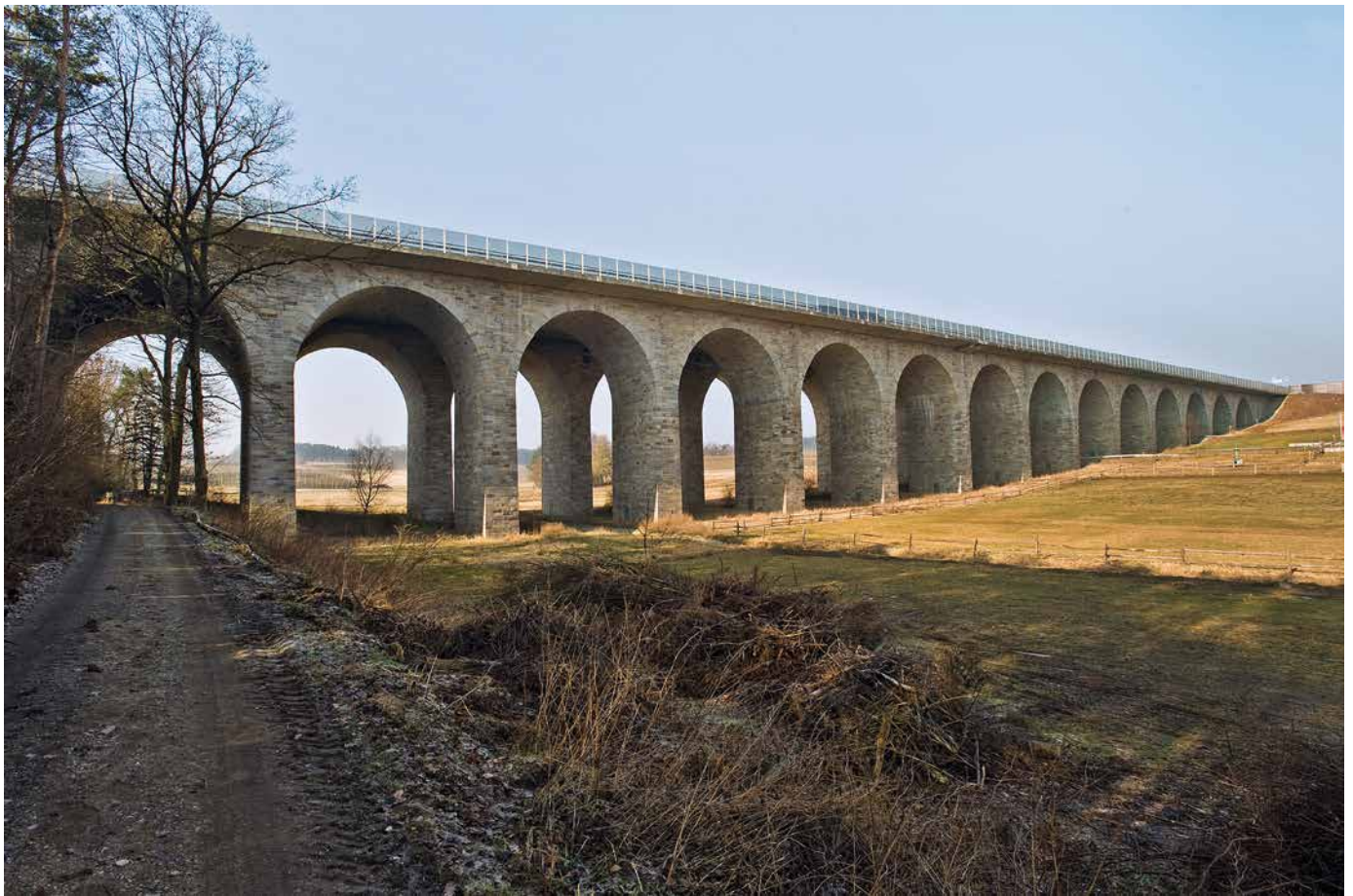
Geisenhausen, Lkr. Pfaffenhofen a.d. Ilm; Hollatau-Autobahnbrücke (Foto: BLfD, Michael Forstner)
