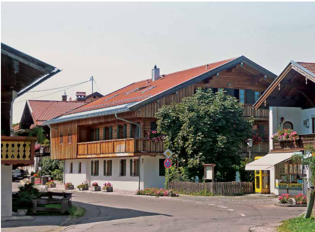
Abb. 14 Greiling, Lkr. Bad Tölz; Solaranlage im Bereich der Dachtraufe (Foto: BLfD)
