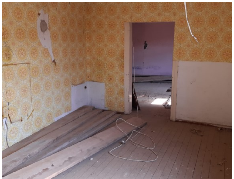
© (E. Häuslein) Sanierungsbedürftige Wohnräume
