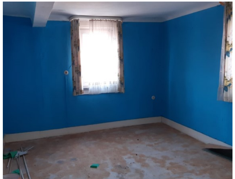
© (E. Häuslein) Sanierungsbedürftiges Zimmer
