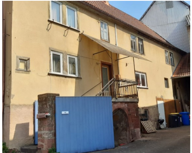
© (E. Häuslein) Historisches Wohnhaus
