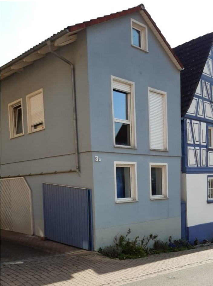
© (E. Häuslein) Neu ausgebautes Nebengebäude
