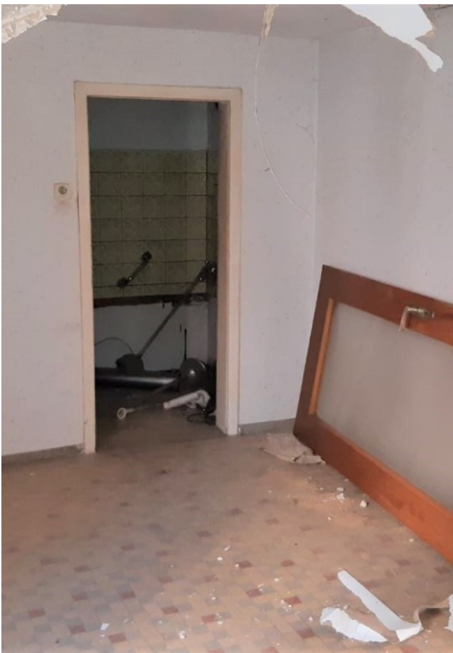
© (E. Häuslein) Zugang zur Küche
