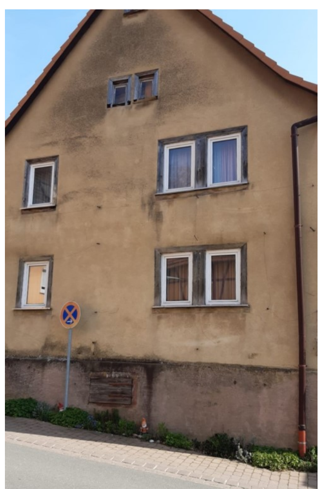
© (E. Häuslein) Stattlicher Satteldachbau
