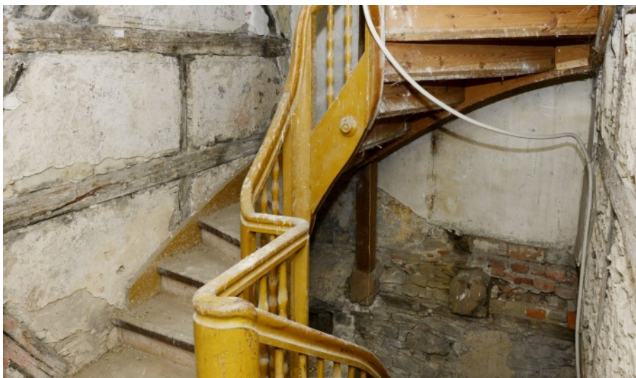
© (G. Gronauer) Historische Treppe ins OG
