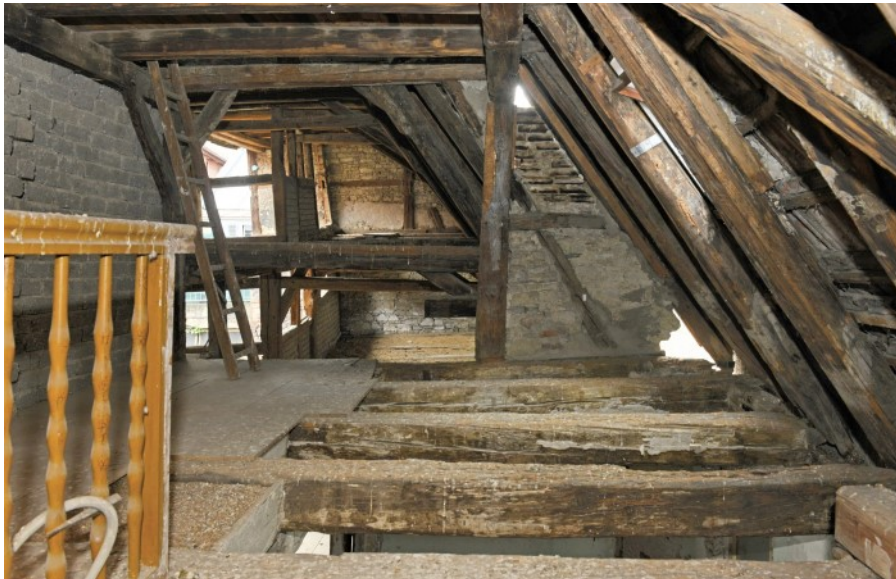
© (G. Gronauer) Historischer Dachbereich
