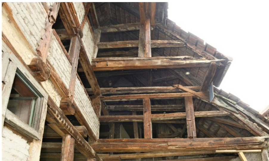
© (G. Gronauer) Dreigeschossige Trockenlaube im rückwärtigen Bereich
