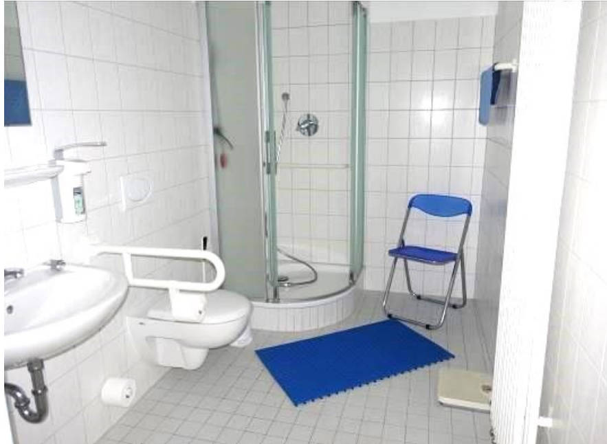
© (M. Stürzenberger) Modernisierte Sanitäranlagen
