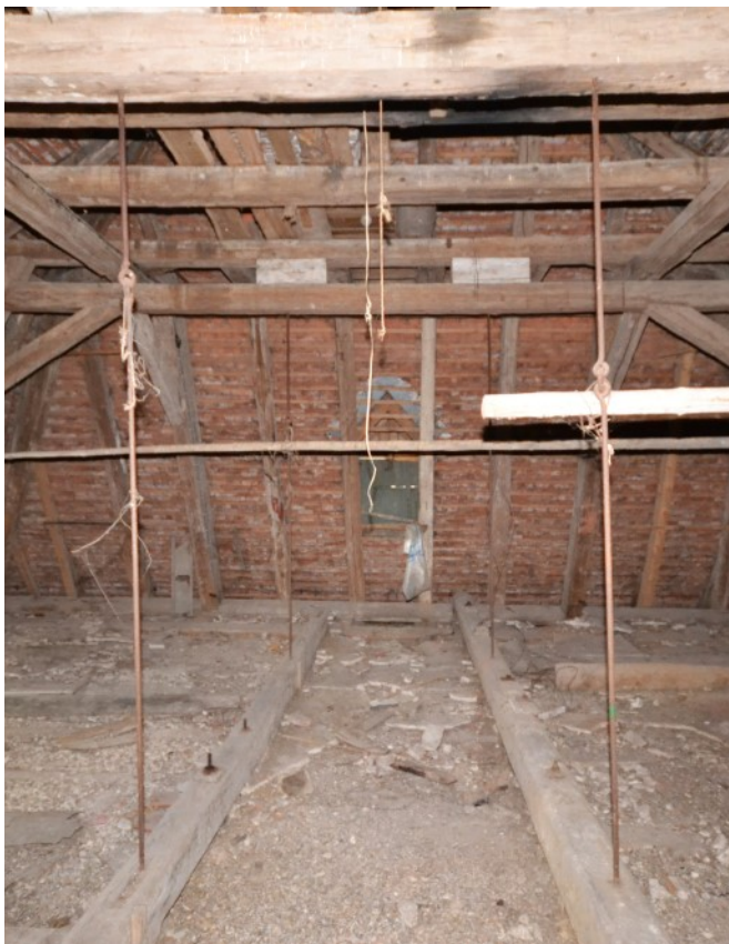
© (G. Gronauer) Städtlicher Dachbereich
