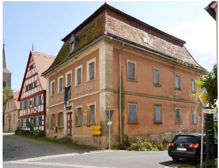
© (G. Gronauer) Städtlicher Barockbau des 18. Jh.
