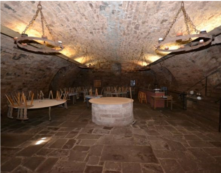
© (G. Gronauer) Historischer Gewölbekeller
