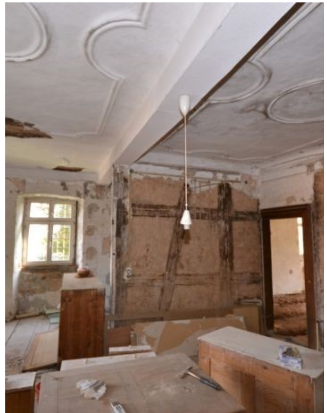
© (G. Gronauer) Sanierungsbedürftige Schlossräume
