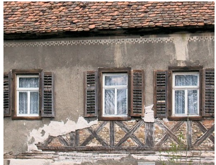
© (BLfD) Historische Fensterfassade
