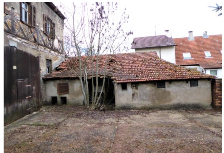
© (M. Mantel) Nicht denkmalgeschützter Anbau
