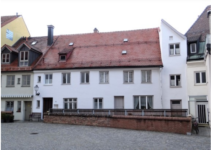
© (D. S. - B.) Rückseite des ehem. Handwerkerhauses
