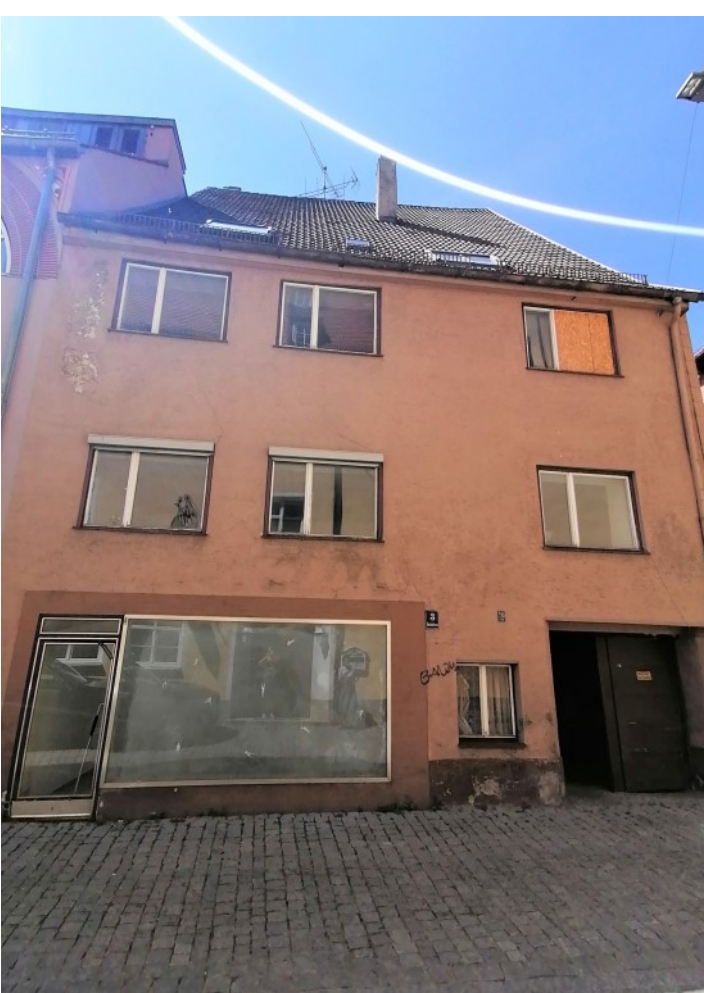
© (S. Lipinski) Historisches Wohn- & Geschäftshaus
