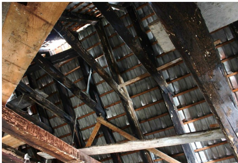
© (S. Lipinski) Historischer Dachstuhl
