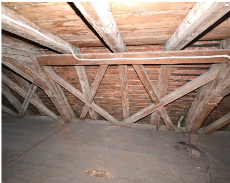
© (G. Gronauer) Großzügiger Dachbereich
