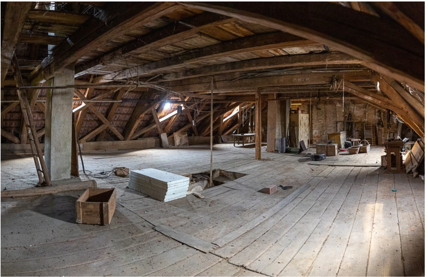
© (J. Schuster) Vielseitig nutzbarer Dachbereich
