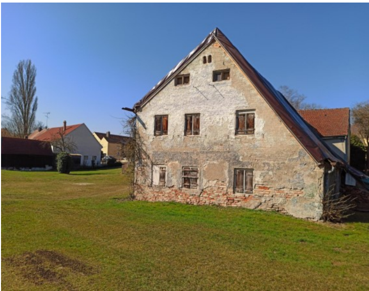
© (E.d.A.) Staudenhaus mit Frackdach
