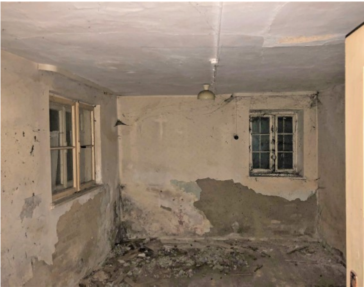
© (E.d.A.) Sanierungsbedürftiger Wohnraum
