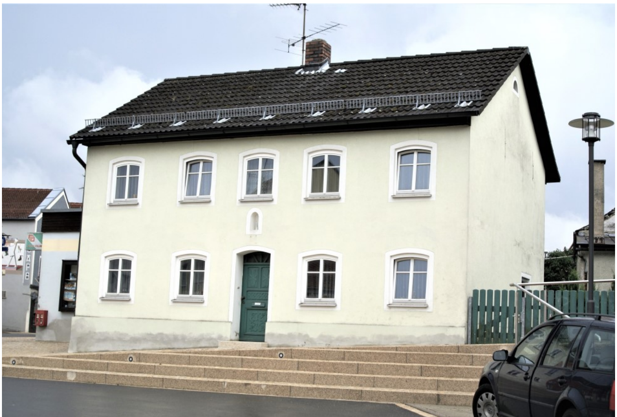
© (E. Böhm) Eindrucksvolles Wohngebäude mit zwei Etagen
