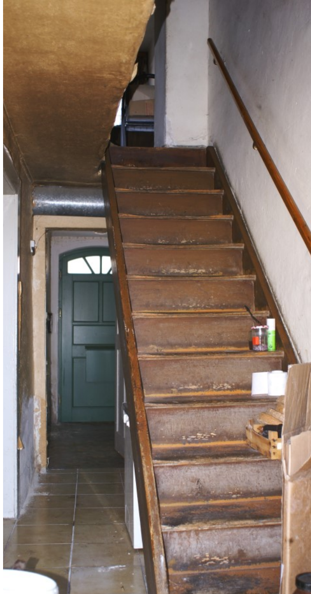
© (E. Böhm) Historischer Eingangsbereich mit Treppe ins OG
