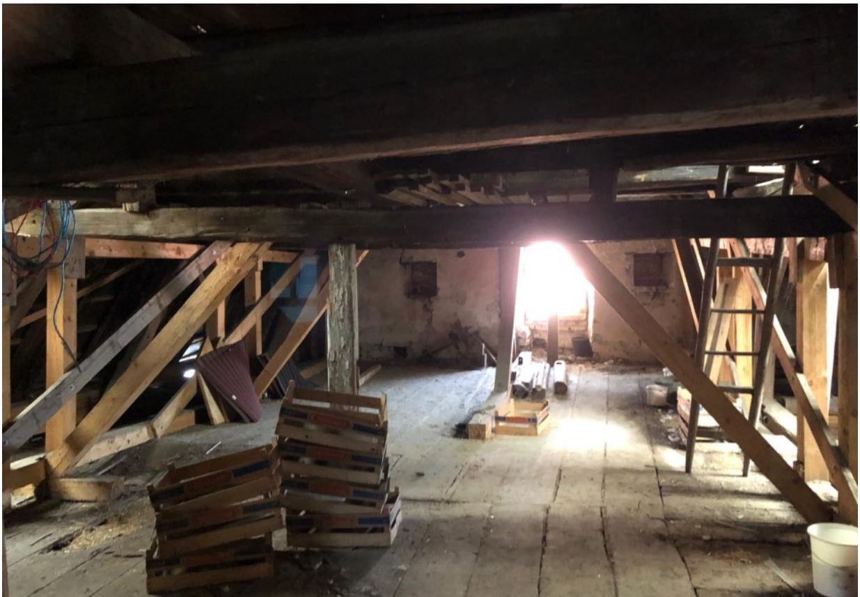
© (S. Kuhnt) Großzügiger Dachraum
