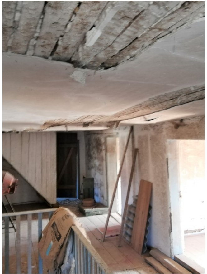
© (M. Angerer) Treppenaufgang ins OG
