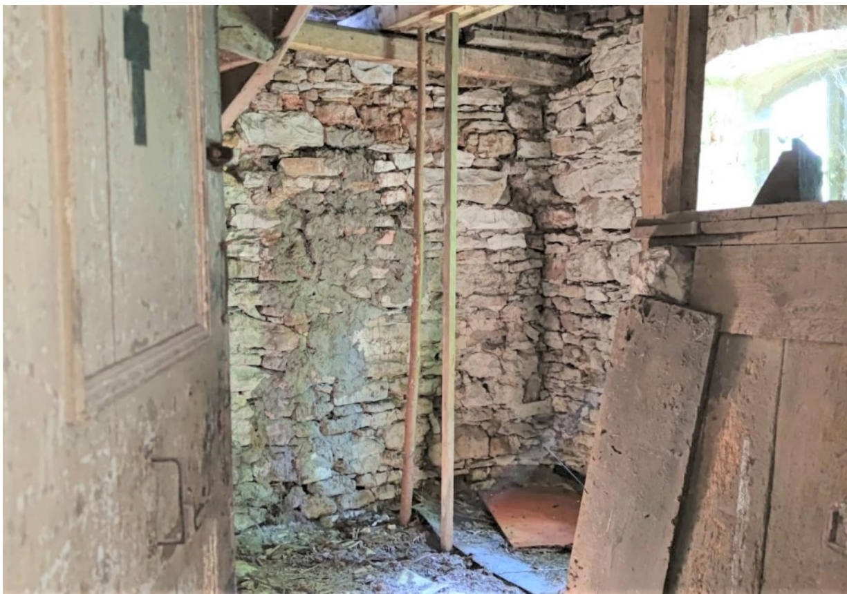
© (P. Hörmann) Raum für zukünftige Sanitäranlagen
