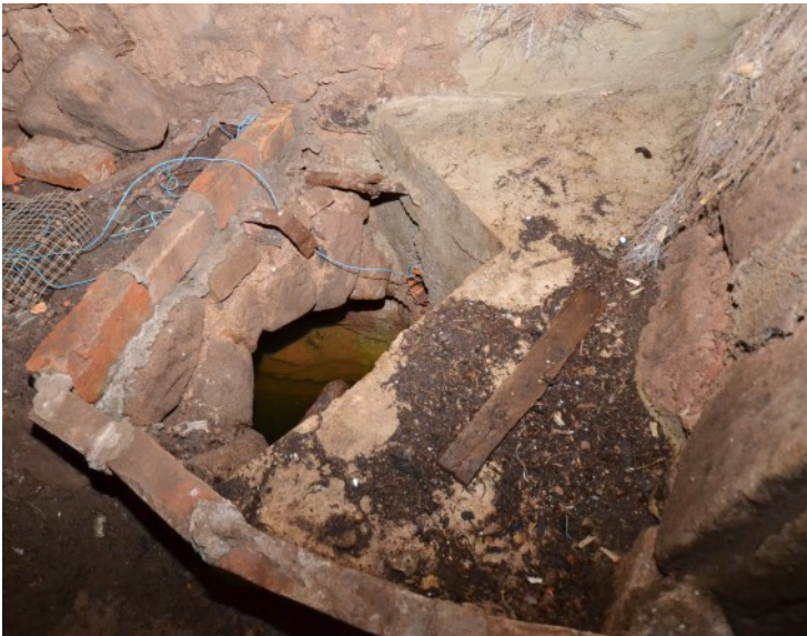
© (G. Gronauer) Grundwasserbrunnen
