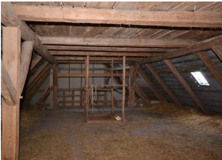
© (G. Gronauer) Historischer Dachbereich
