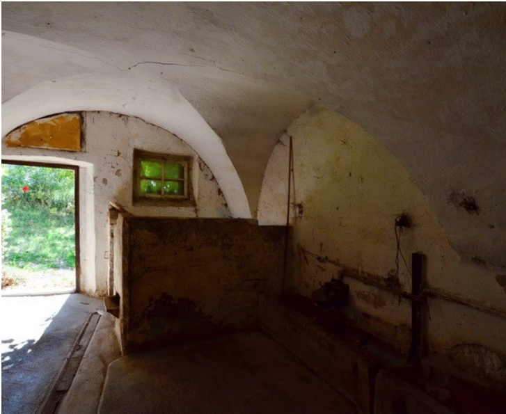
© (EdA) Kreuzgewölbedecke im ehem. Kuhstall
