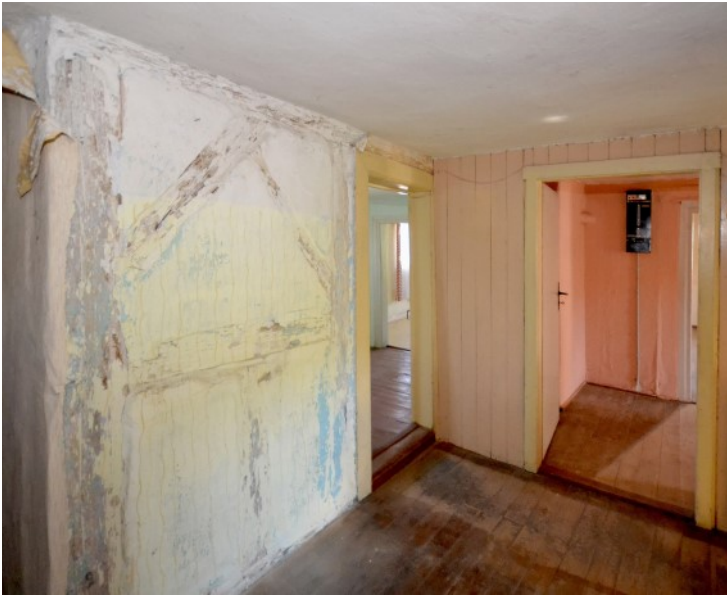
© (G. Gronauer) Flur mit Fachwerkständerwand
