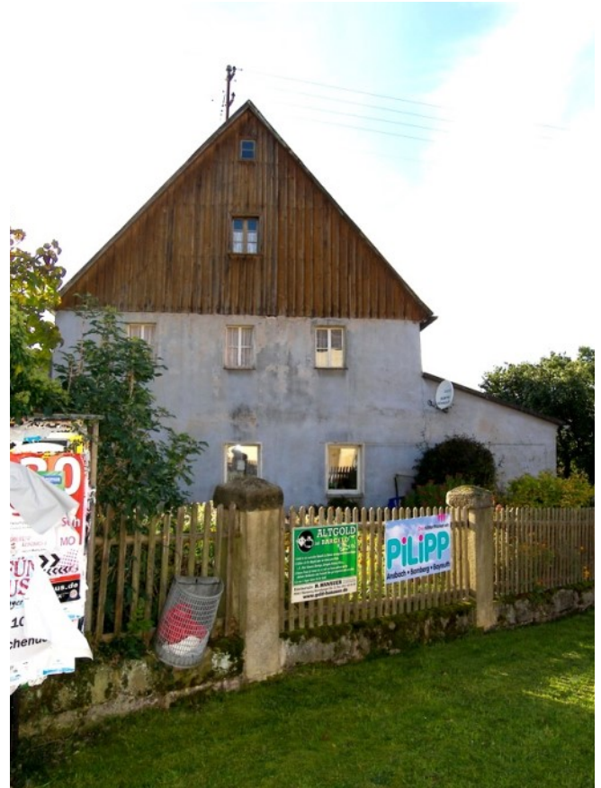
© (EdA) Bauernhaus mit verbrettertem Giebel
