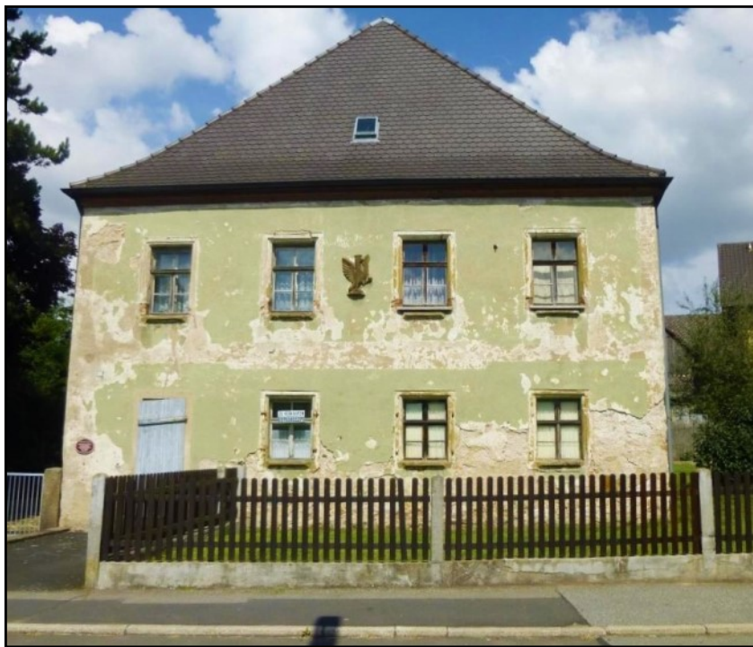
© (BLfD) Das Pfalz-Sulzbachische „Jagdschlössl“ in Mantel
