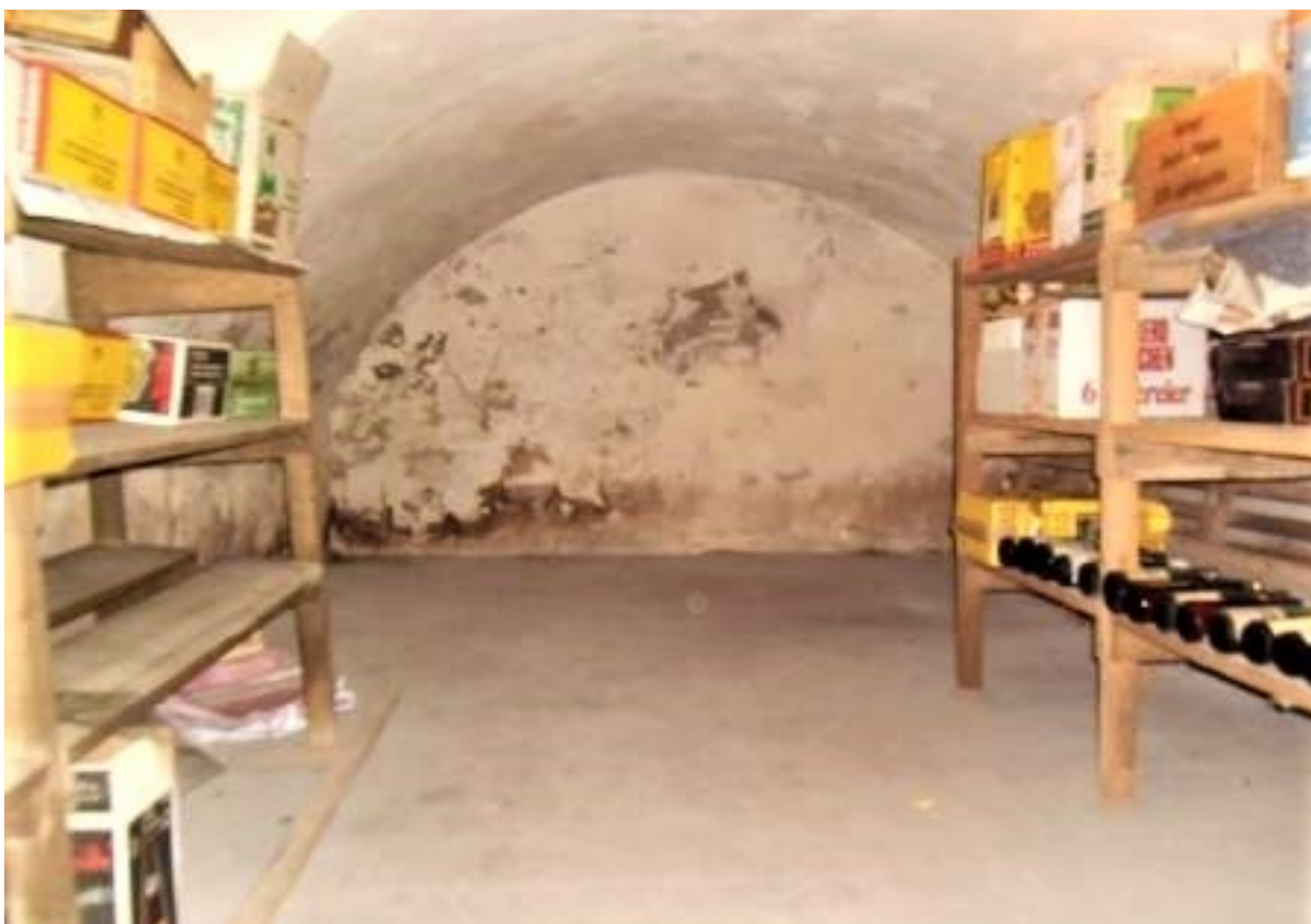
© (E. d. A.) Historischer Gewölbekeller
