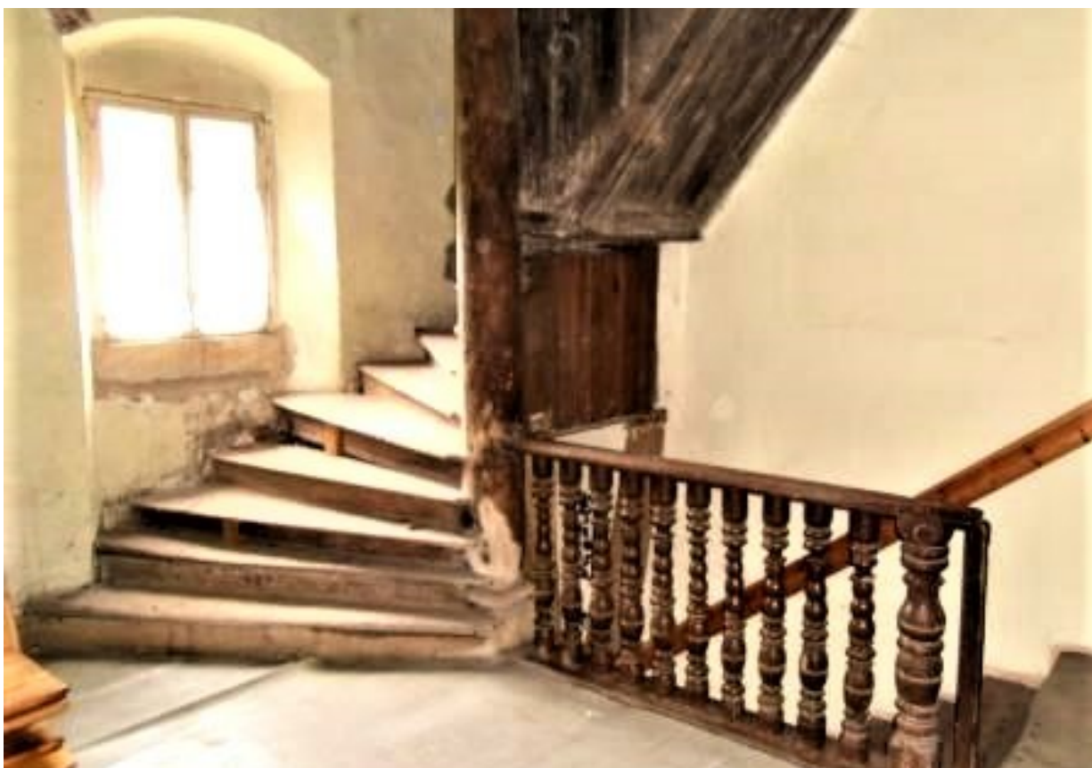
© (E. d. A.) Historische Balustertreppe ins OG
