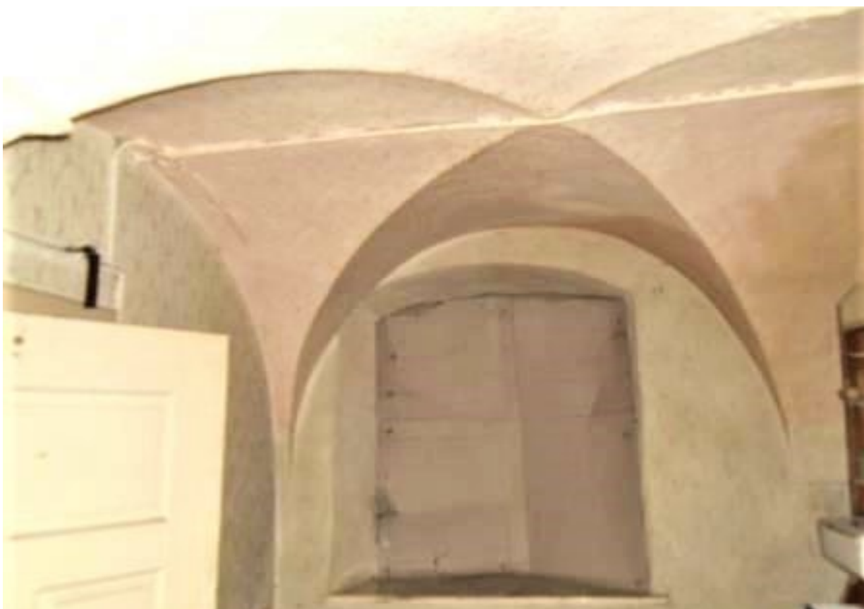
© (E. d. A.) Böhmisches Kreuzgewölbe im EG
