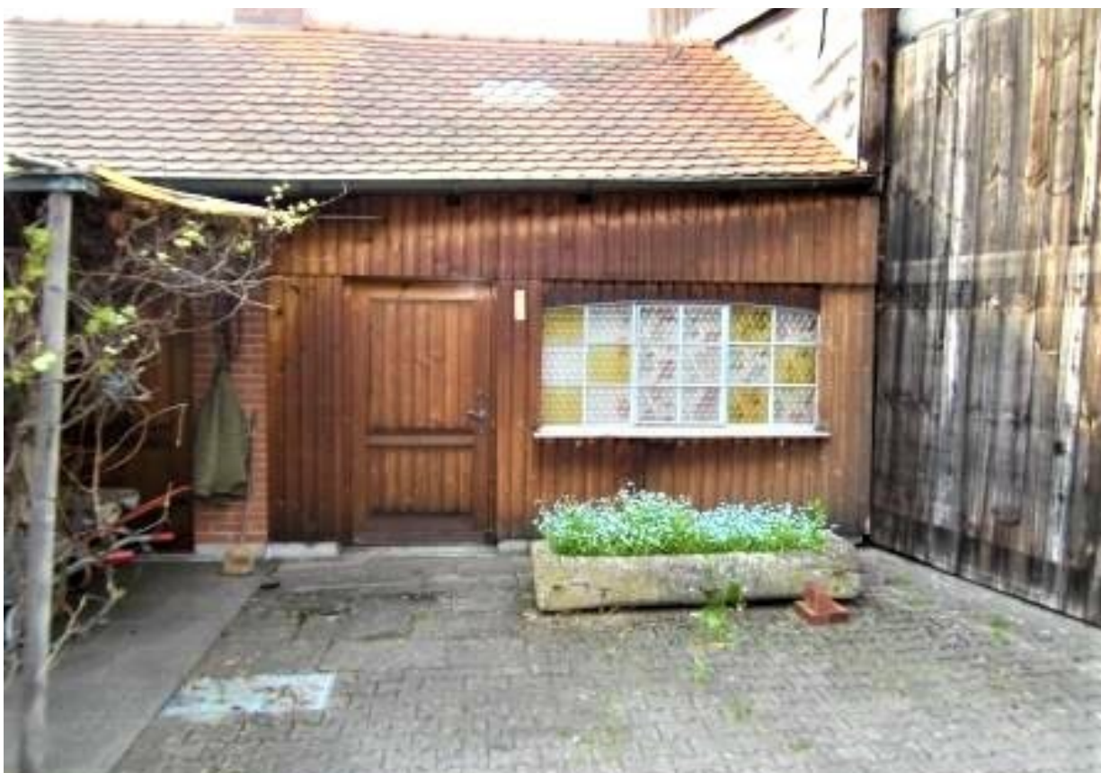
© (E. d. A.) Niedliches Wochenendhäuschen mit Terrasse
