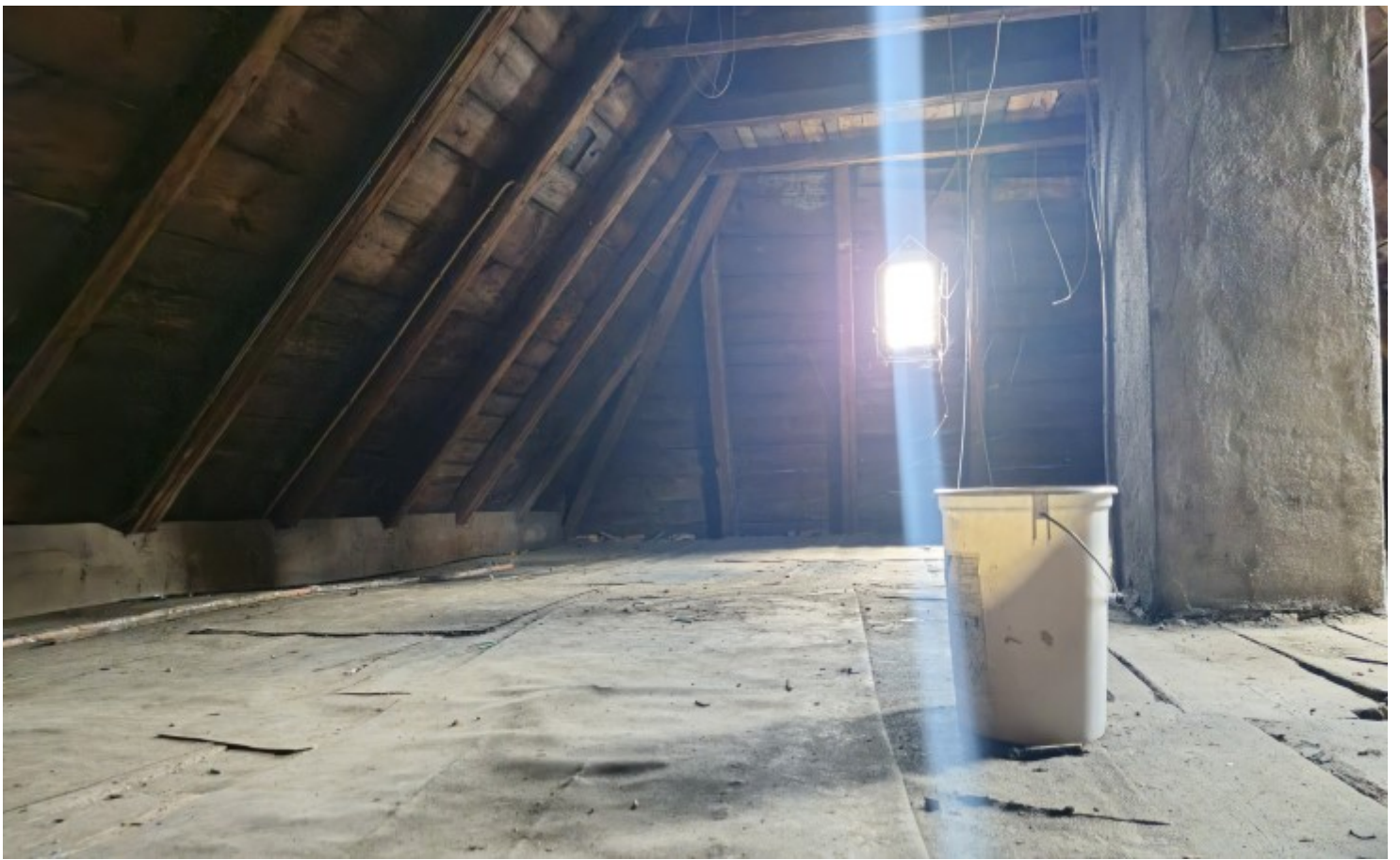
© (Stadt Kirchenlamitz) Dachboden
