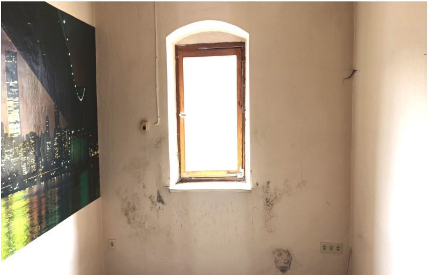
© (Stadt Kirchenlamitz) Zimmer im Dachgeschoss
