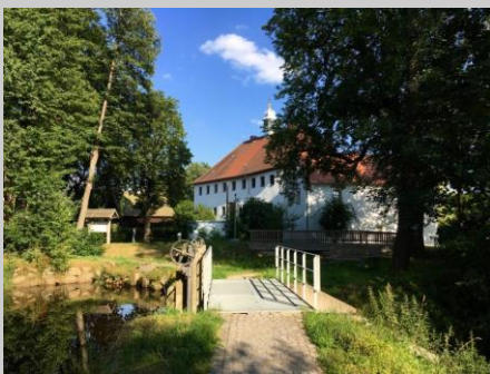
Brücke über die Röslau
