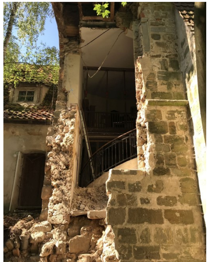
© (BLfD) Sanierungsbedürftiger Schlossteil
