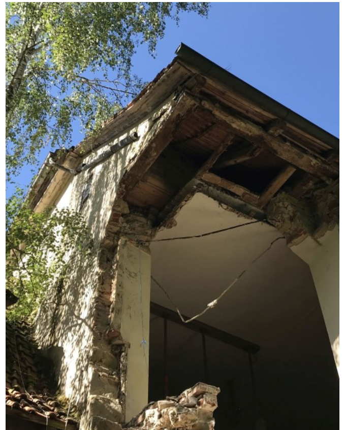
© (BLfD) Sanierungsbedürftiger Bereich
