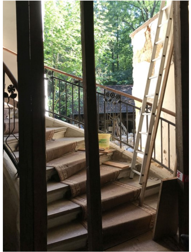
© (BLfD) Sanierungsbedürftiger Gebäudeteil
