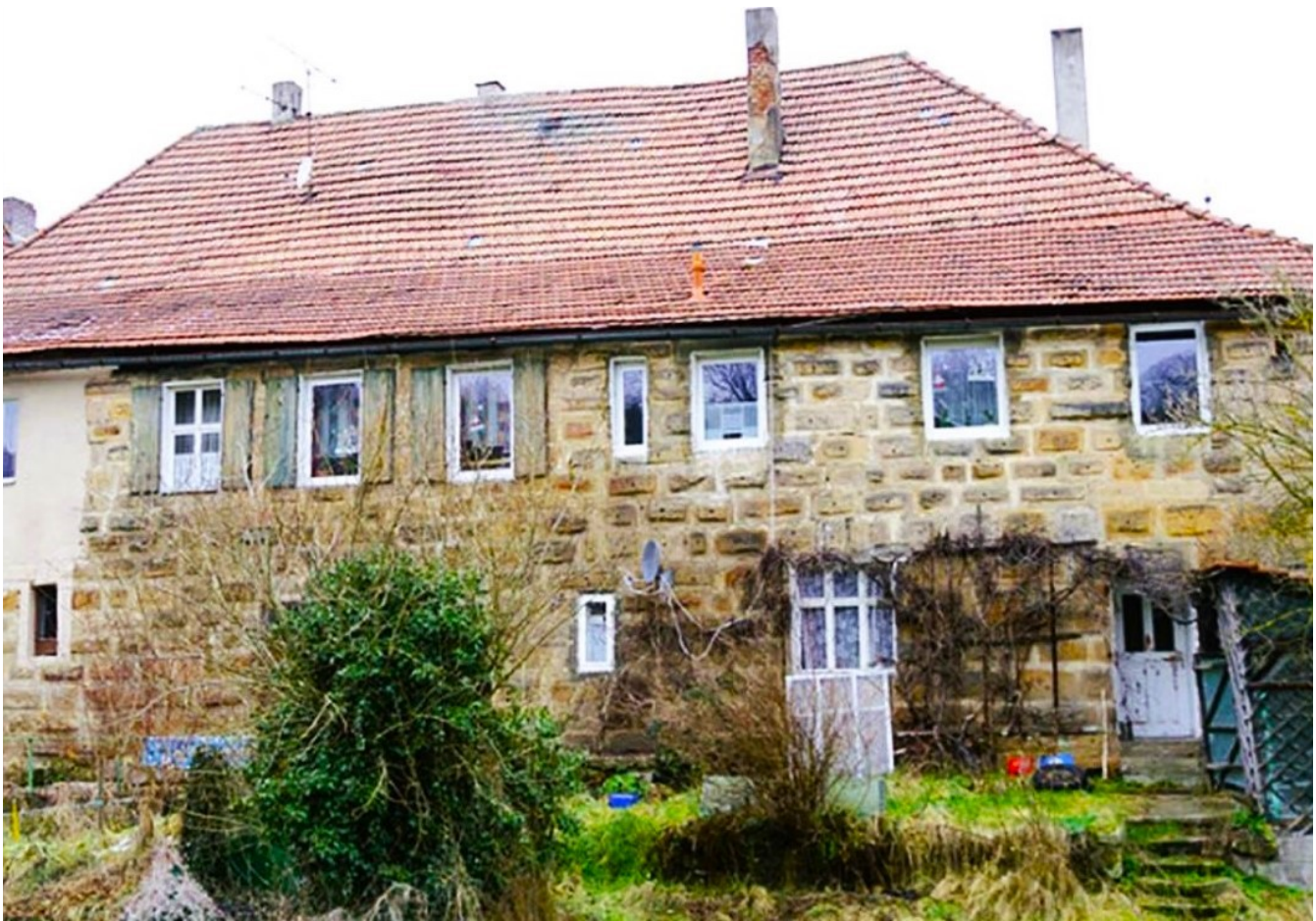
© (A. Göldner) Gebäuderückseite mit anschließendem Garten
