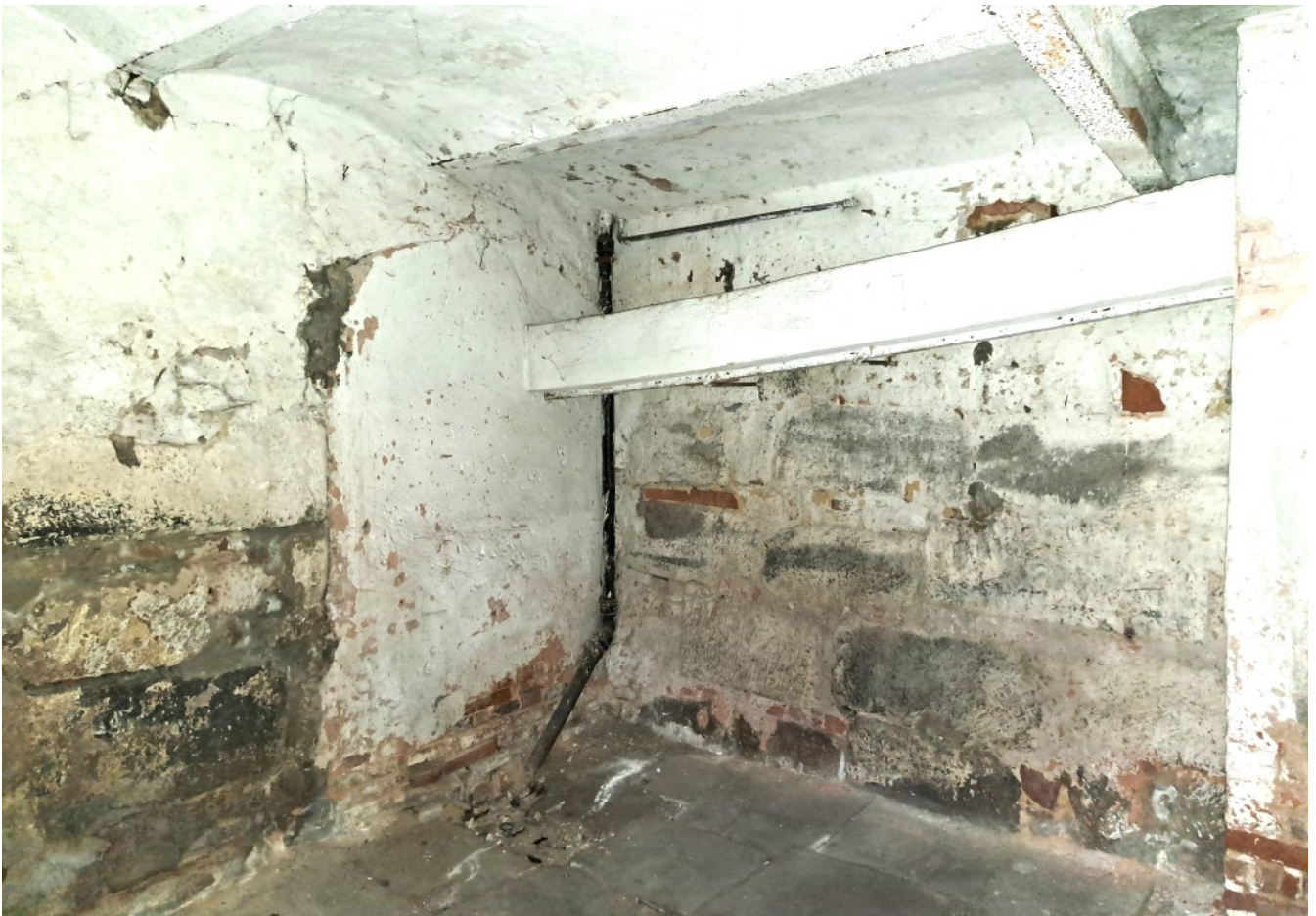
© (A. Göldner) Sog. Hofraum mit Gewölbedecke im EG von Haus Nr. 17
