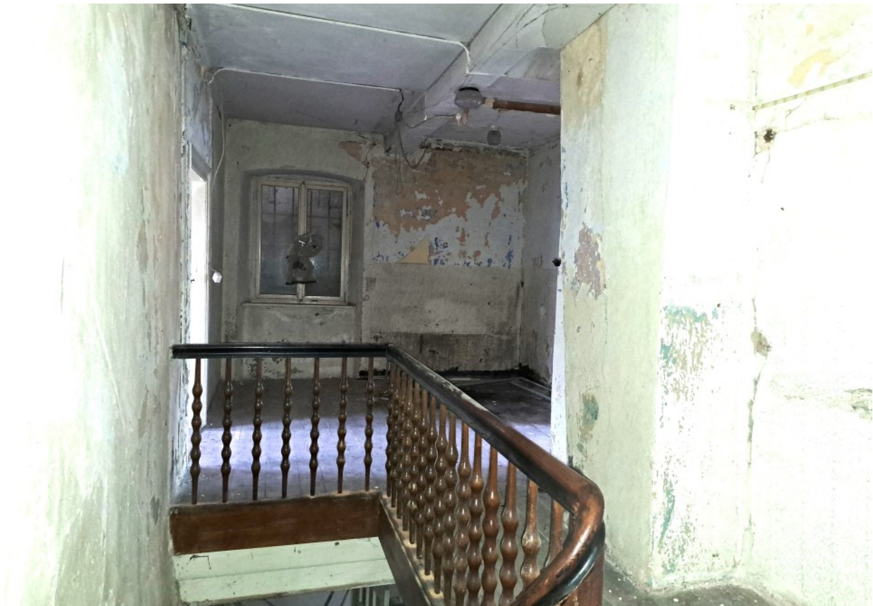
© (A. Göldner) Treppenaufgang mit Balustertreppe in Haus Nr. 17
