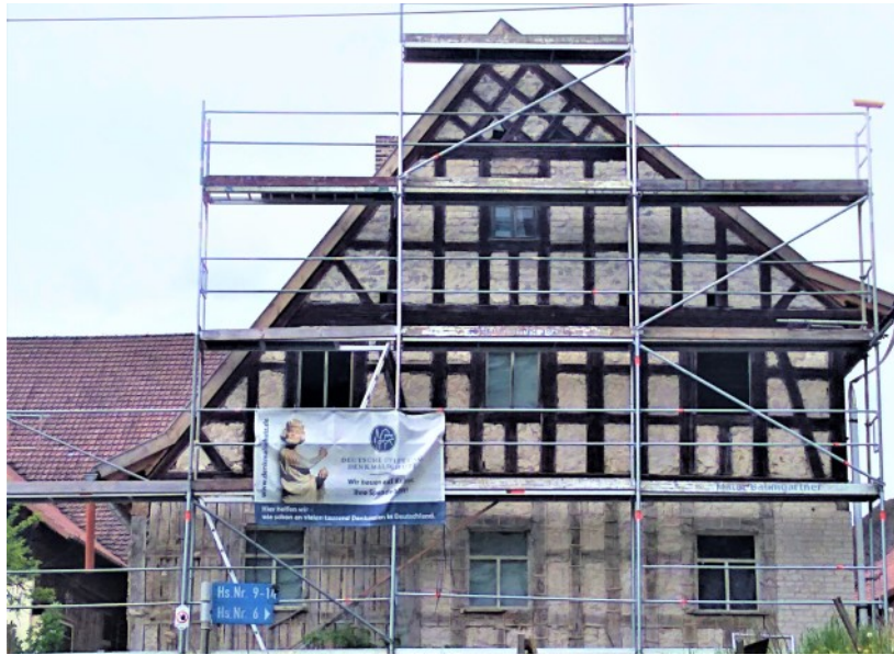
© (H.-W. Fischer) Sanierung der Fassade
