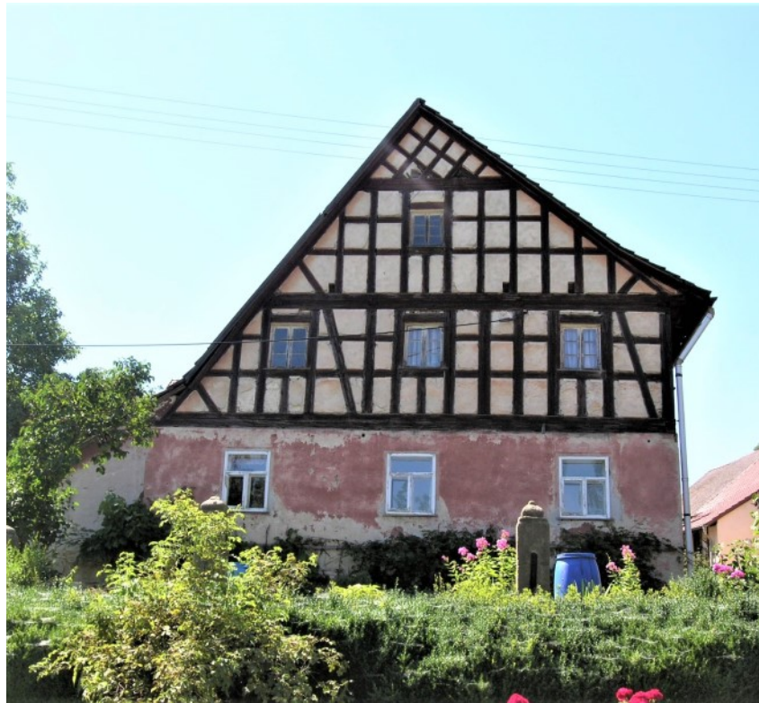
© (BLfD) Bildschöner Frackdachbau vor seiner Sanierung
