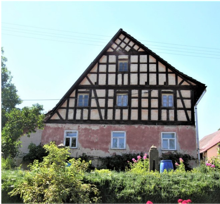
© (BLfD) Bildschöner Frackdachbau vor seiner Sanierung
