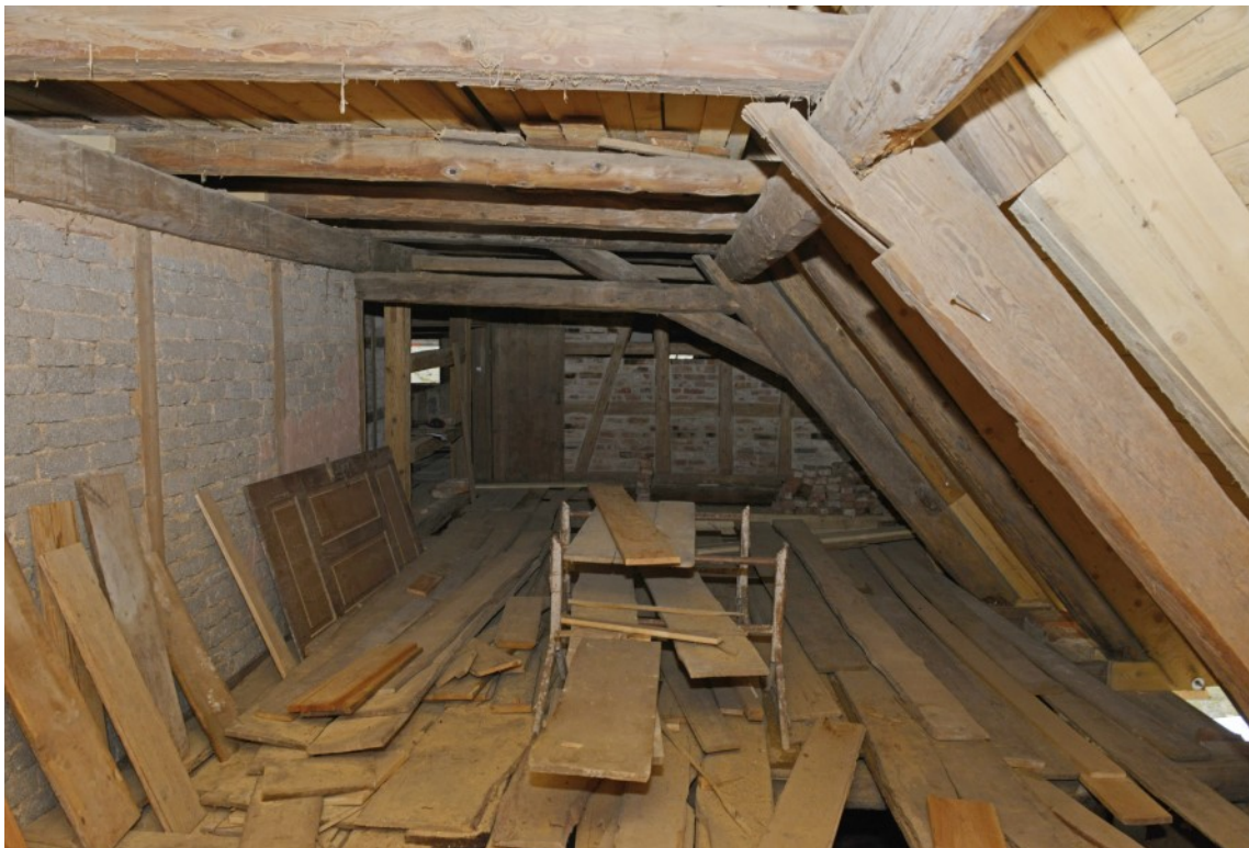
© (G. Gronauer) Großzügiger Dachbereich
