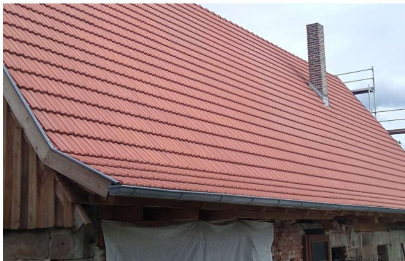
© (E.d.A.) Neueingedecktes Dach
