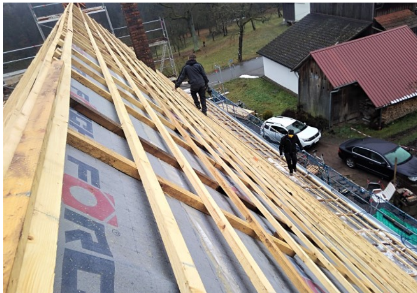
© (E.d.A.) Sanierungsarbeiten am Dach
