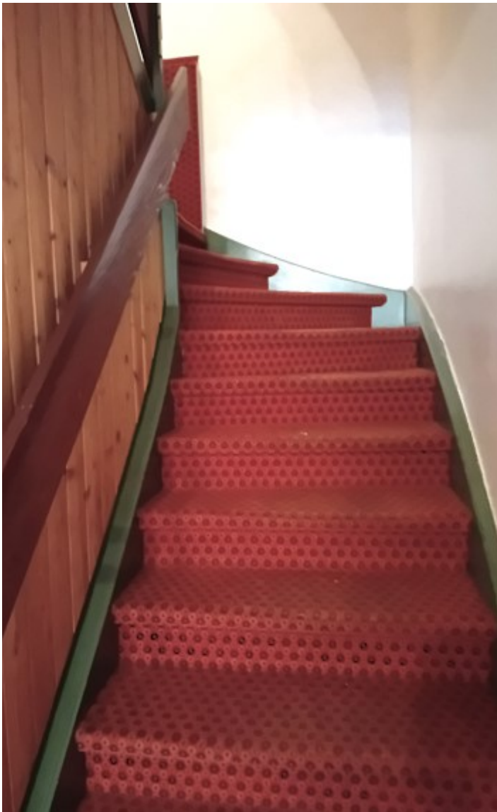
© (H. Baumann) Treppe ins OG
