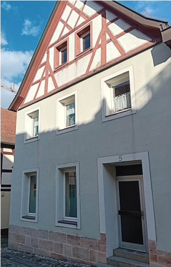
© (H. Baumann) Herrlicher Altstadtbau mit Sandsteinsockel
