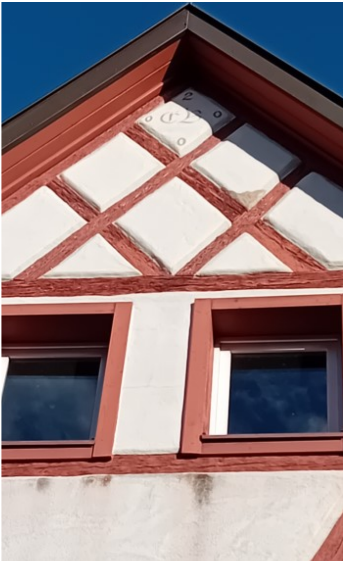
© (H. Baumann) Freigelegter Fachwerkgiebel
