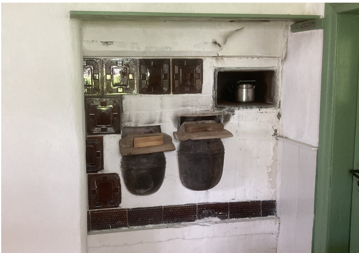
© (A. Schelter) Hinterladerkachelofen - beheizbar von der Küche
