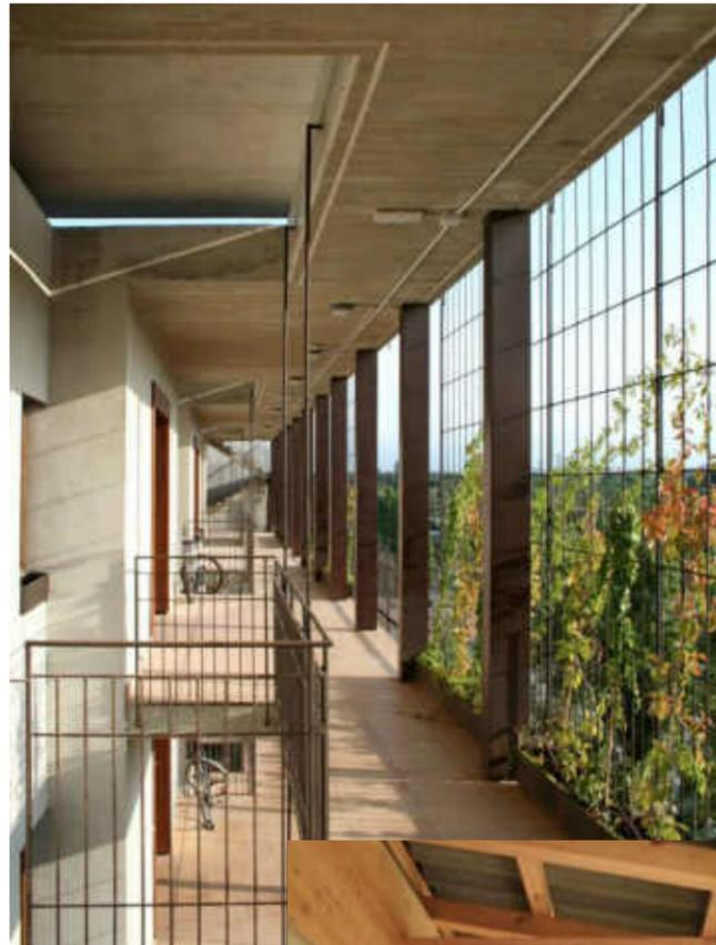
Abb. 56 Laubengang mit vorgehängter Gitterstruktur aus Stahl und Pflanzranken
