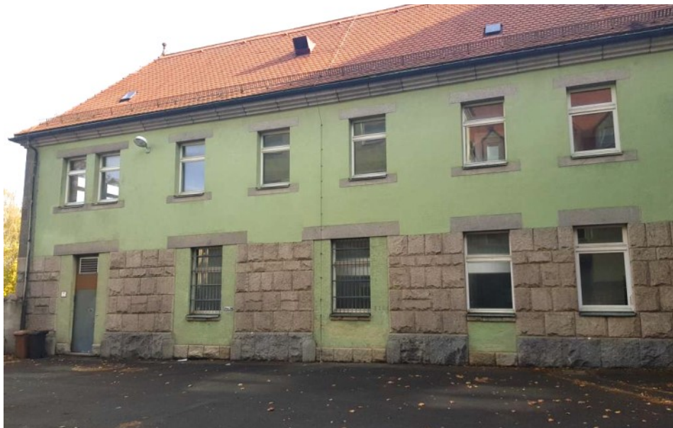
© (J. Butscher) Beachtliches Bauwerk in Massivbauweise von seiner Hofseite
