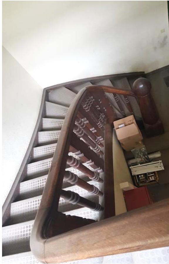
© (J. Butscher) Historische Treppe
