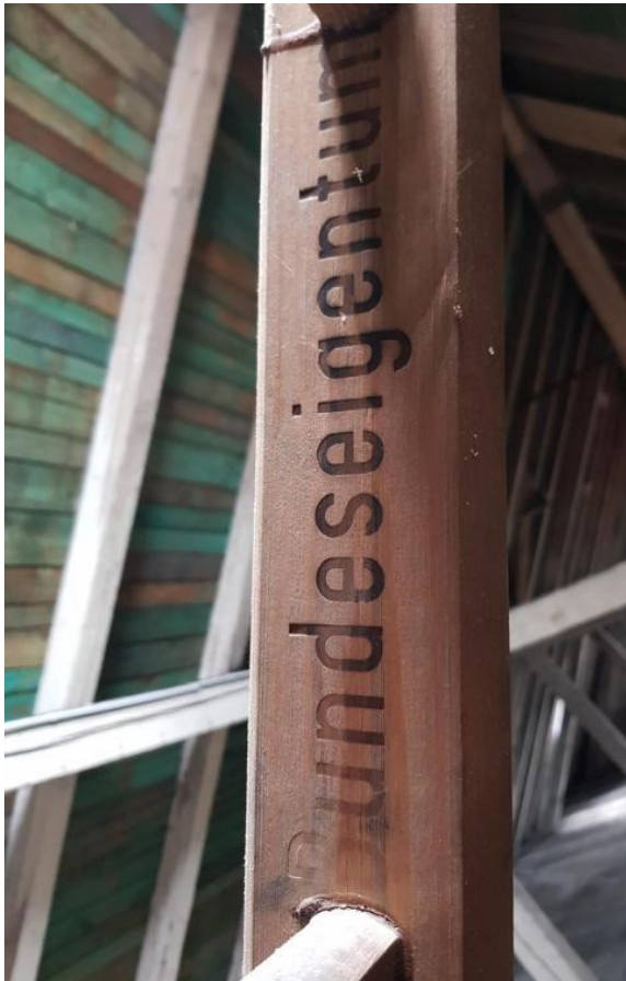
© (J. Butscher) Historischer Dachstuhl
