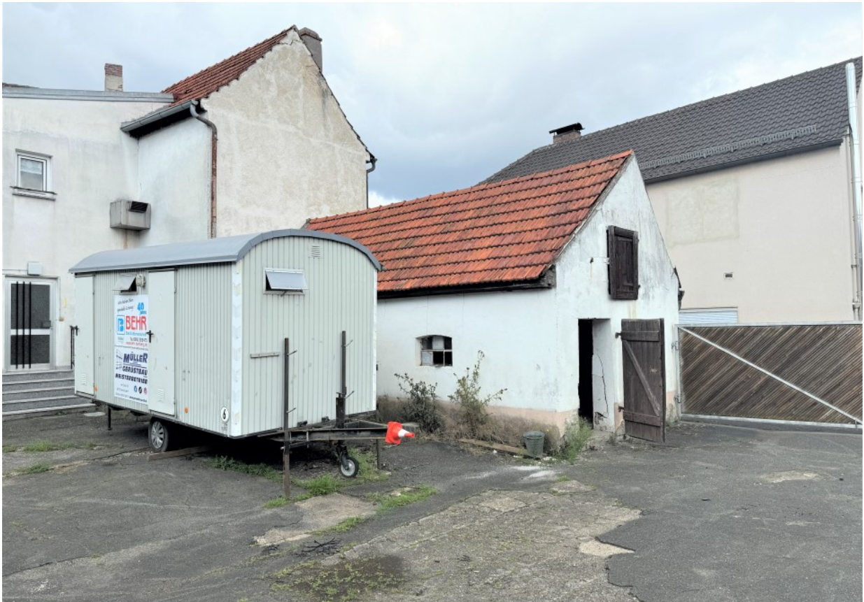
© (C. Schmitt) Neuerer Wohnhausanbau mit Stallgebäude
