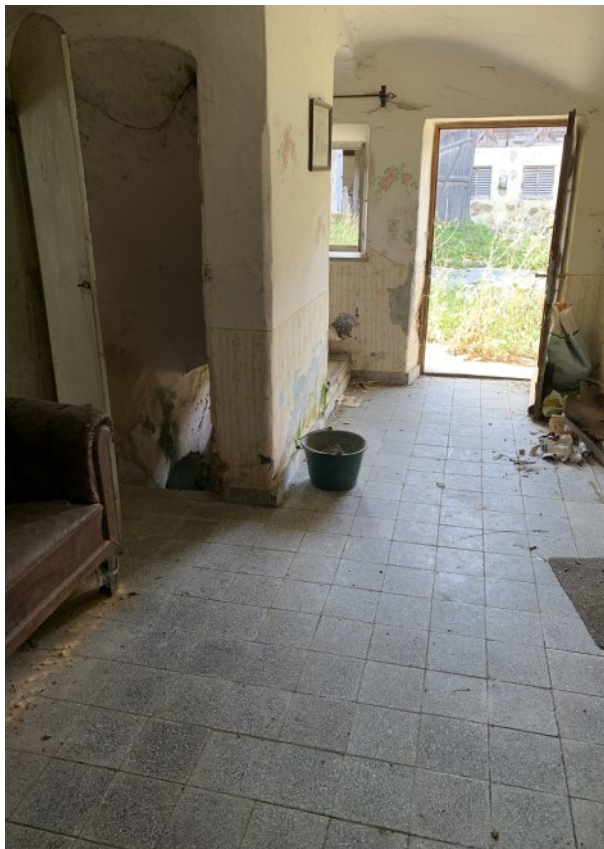
© (T. Dunstmair) Flurbereich mit Zugang zum Keller
