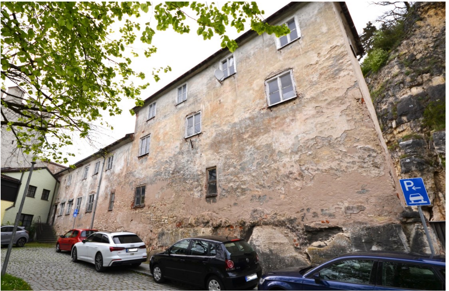
© (G. Gronauer) Dreigeschossiger, turmartiger Gefängnisbau in Jurabauweise
