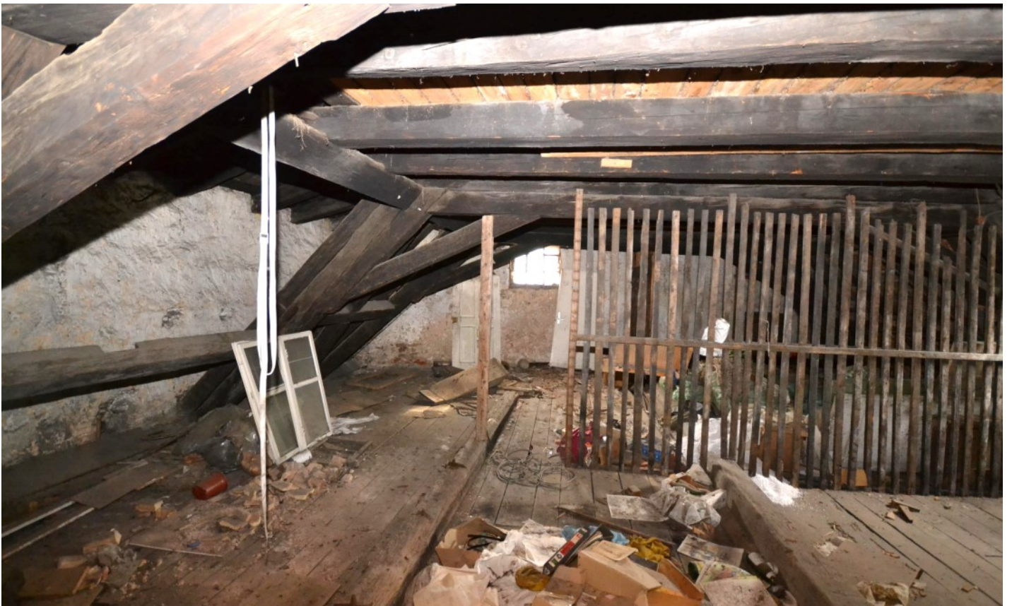
© (G. Gronauer) Großzügiger Dachbereich
