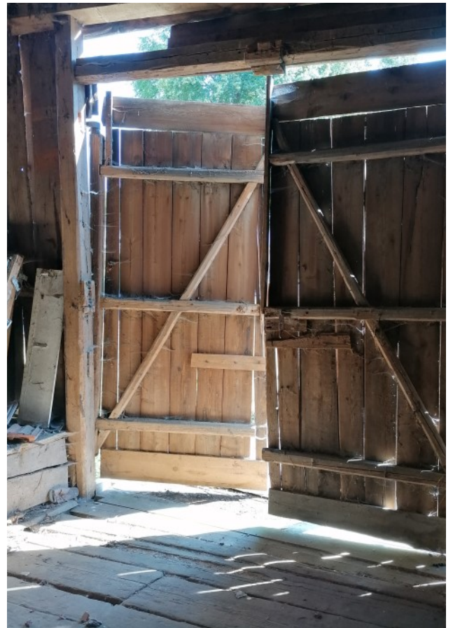
© (BLfD) Scheunentor an der Gebäude- rückseite
