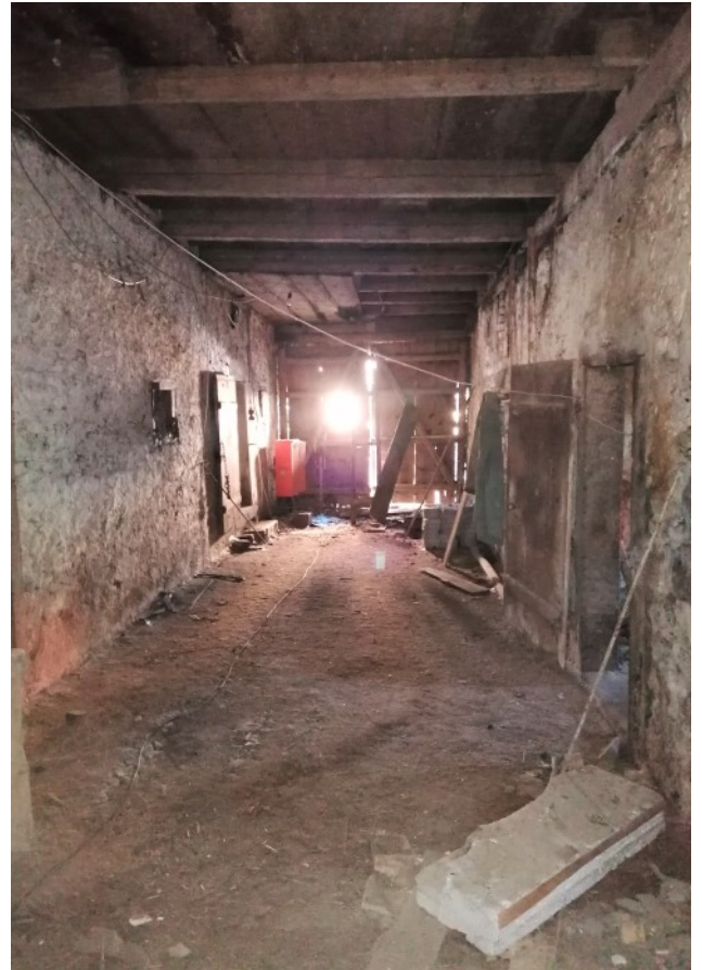
© (BLfD) Tordurchfahrt zum beachtlichen Wirtschaftsteil
