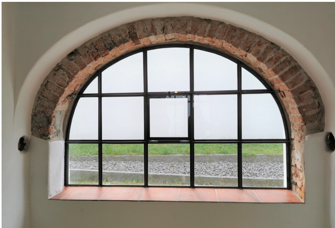
© (E. d. A.) Historisches Fenster im Flur
