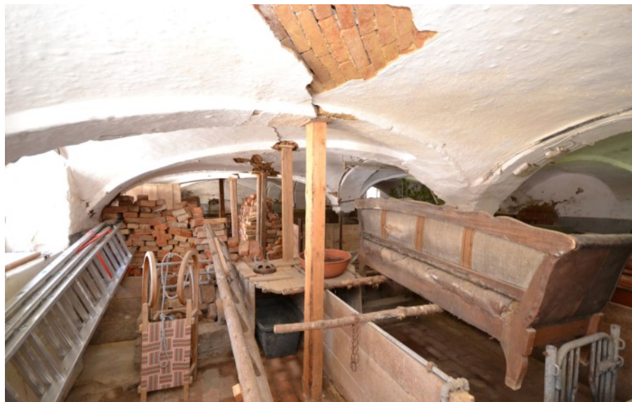
© (G. Gronauer) Historische Stallungen mit Gewölbe
