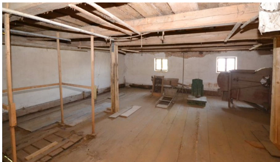
© (G. Gronauer) Vielseitig nutzbare Räumlichkeiten des ehemaligen Schweine- und Kuhstalls
