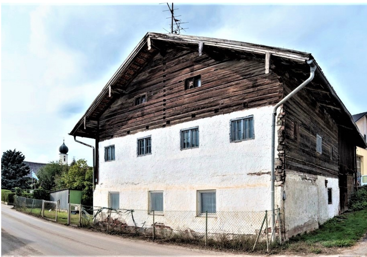
© (Herbert Stolz) Wohnteil mit versteinertem EG und Blockbau-OG
