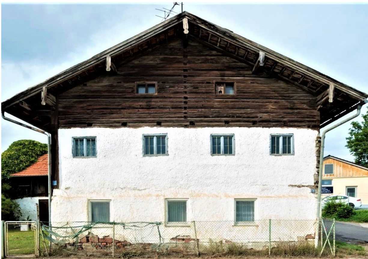
© (Herbert Stolz) Wohnteil mit vorkragendem Satteldach und Giebelbrettern
