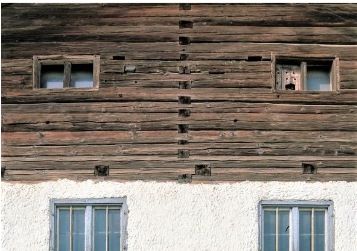
© (Herbert Stolz) Giebelfassade in Massiv- und Blockbauweise
