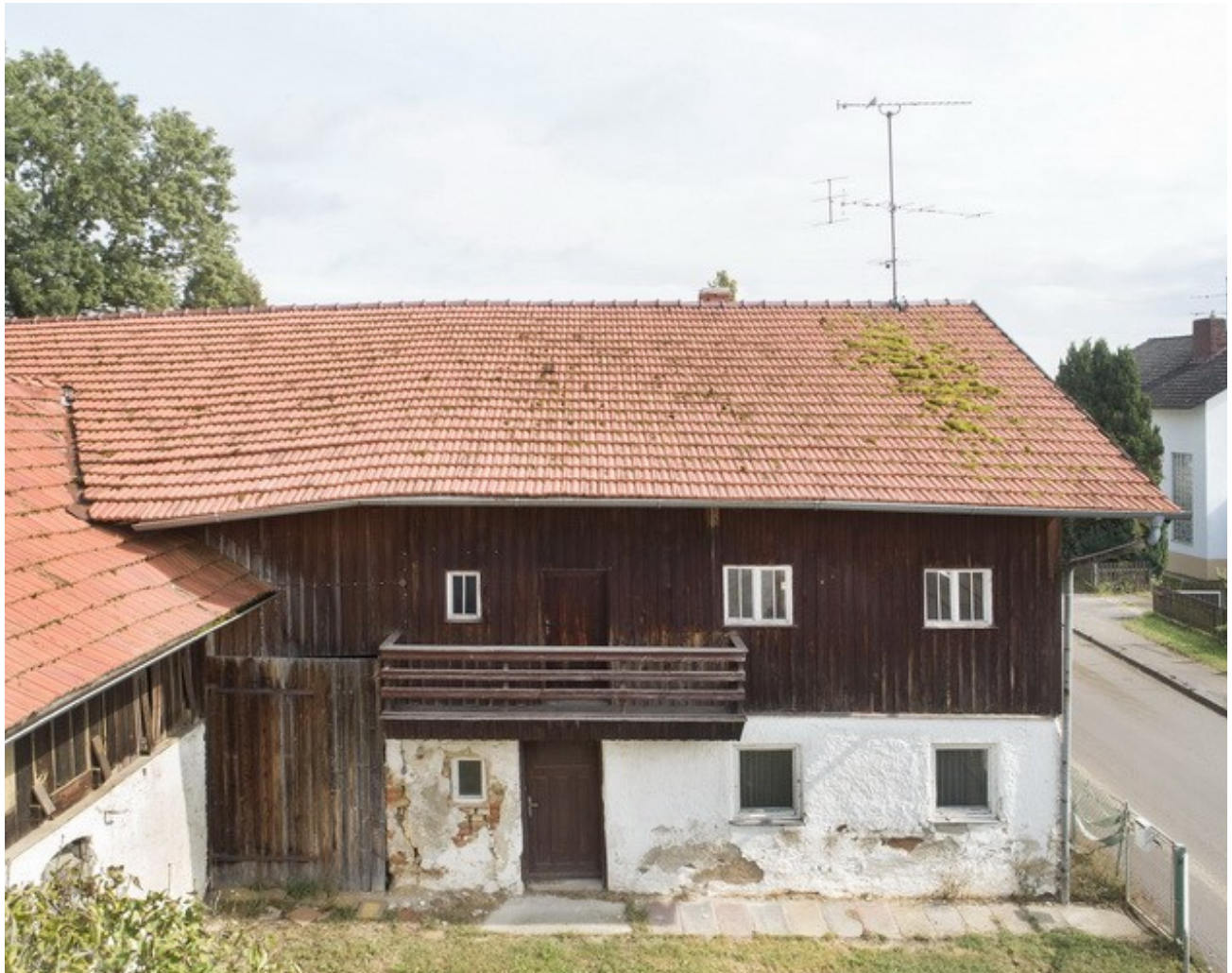
© (Herbert Stolz) Historische Hofanlage mit Wohnteil, Scheune (Tenne) und Stall
