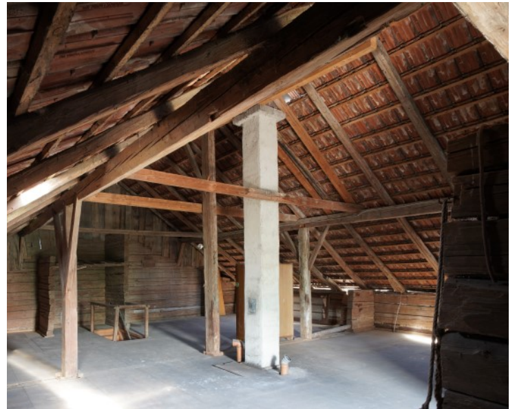
© (T. Drexel) Historischer Dachbereich
