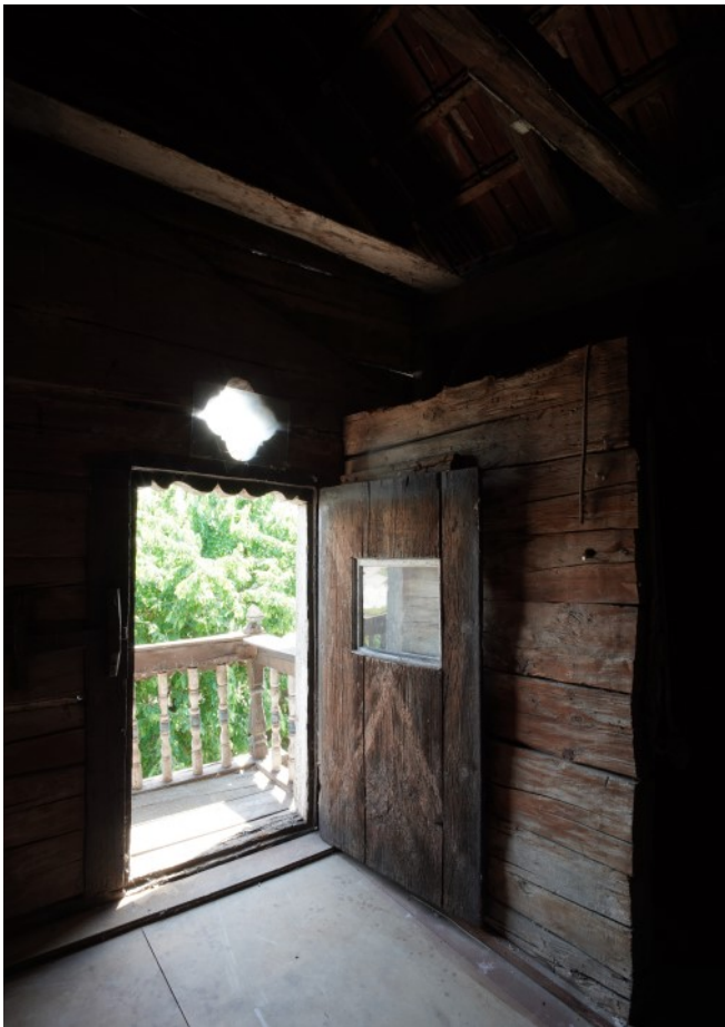
© (T. Drexel) Zugang zum Giebelschrot im DG
