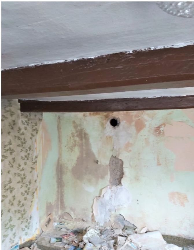
© (H. J. Kaftan) Zimmer mit Deckenbalken
