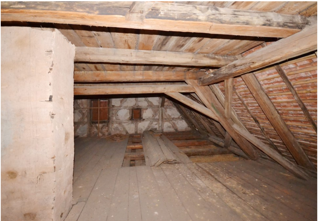
© (Die Denkmalschutz Immobilie) Historischer Dachstuhl
