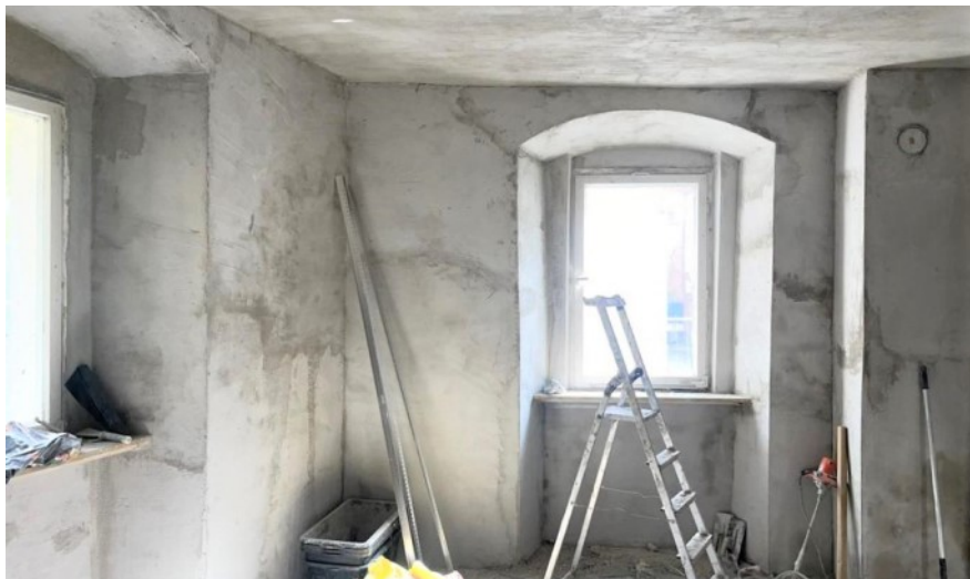
© (A. Haschke) Historisches Zimmer, bereit zur weiteren Renovierung
