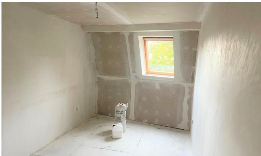
© (A. Haschke) Zimmer im Mansarddachgeschoss
