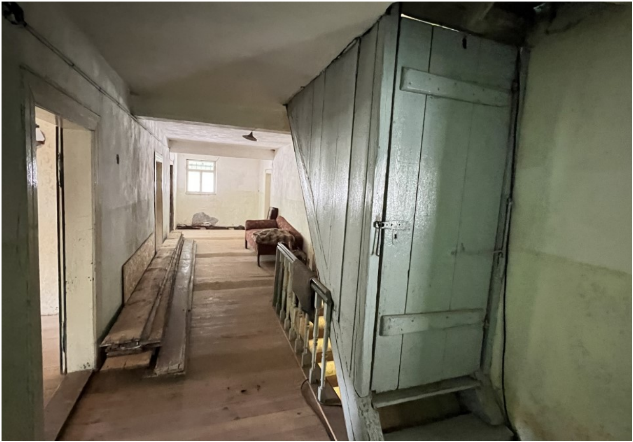
© (U. Böckl) Flurbereich mit historischer Treppe ins DG
