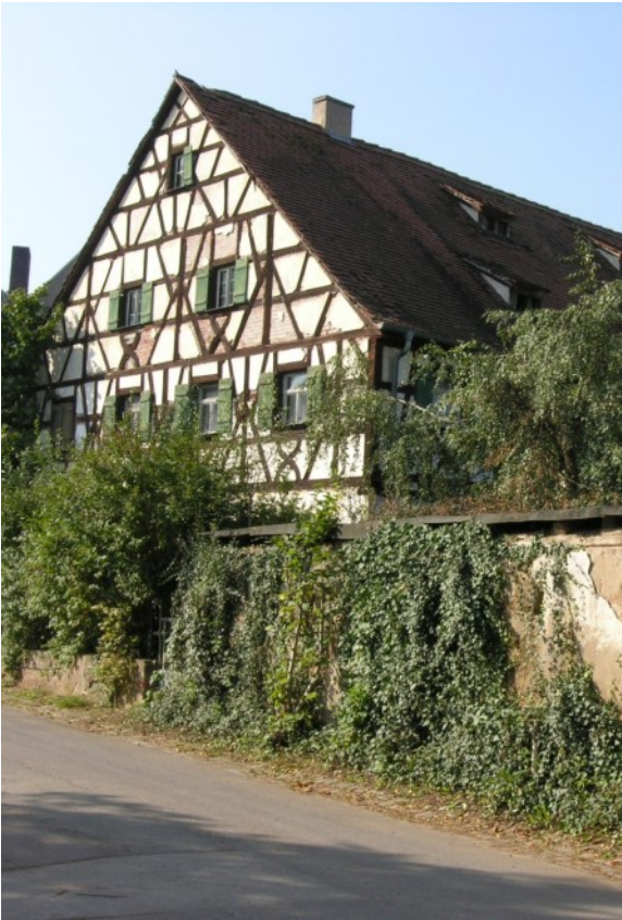
© (BLfD) Mächtiger Satteldachbau des frühen 19. Jahrhunderts
