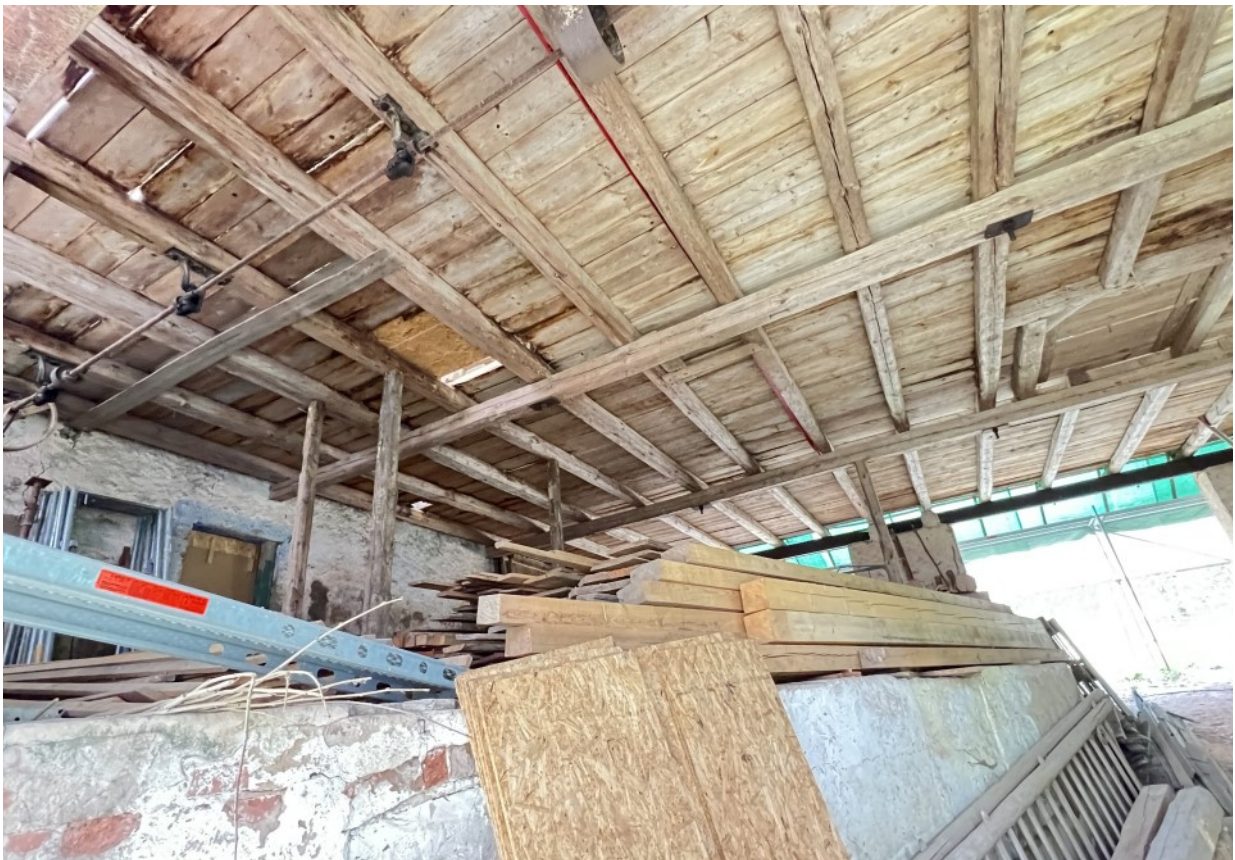
© (U. Böckl) Beachtliche Nutzfläche in der Scheune
