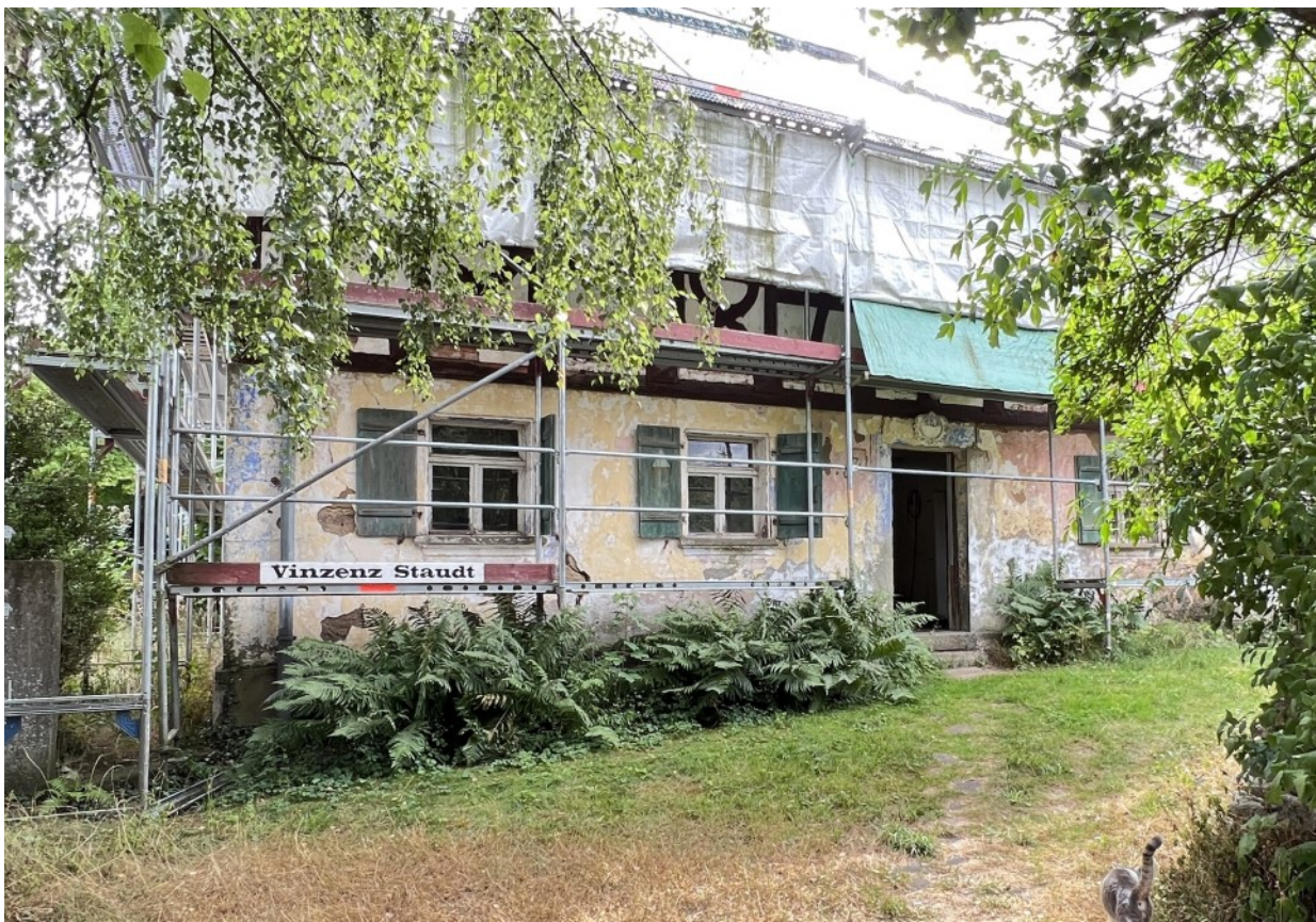
© (U. Böckl) Beginnende Sanierung des Wohnstallhauses
