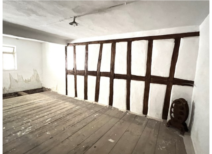
© (U. Böckl) Wohnraum mit Sichtfachwerk im OG
