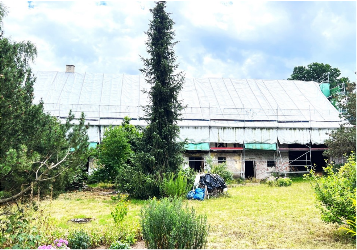
© (U. Böckl) Sanierungsarbeiten am Wohnstallhaus
