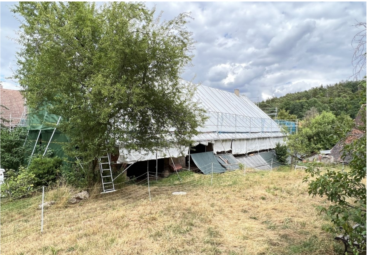
© (U. Böckl) Komplette Einhausung des Daches
