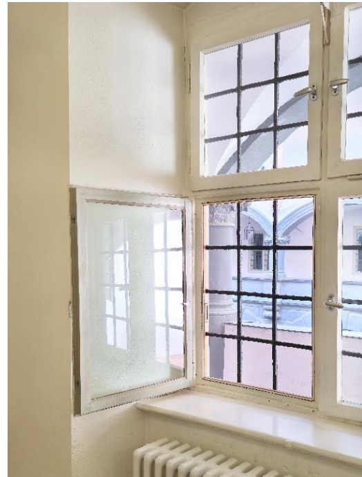
Fensterflügel mit Vakuum-Isolierglas, eingefräste Schlauchdichtungen
