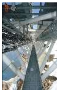
Funkübertragungsstelle, nördliche Antennenbrücke Foto: Knipping, Bayer. Landesamt für Denkmalpflege
