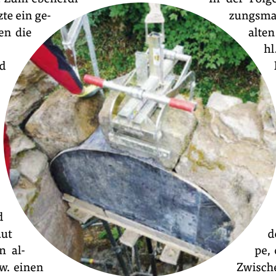
Sicherung des Wehrerkers (Baualtersplan Nr. 15): Einfügen der Bogensteine durch die Firma Kirchner Bau Foto: © Büro für Burgenforschung Dr. Zeune, 2018
