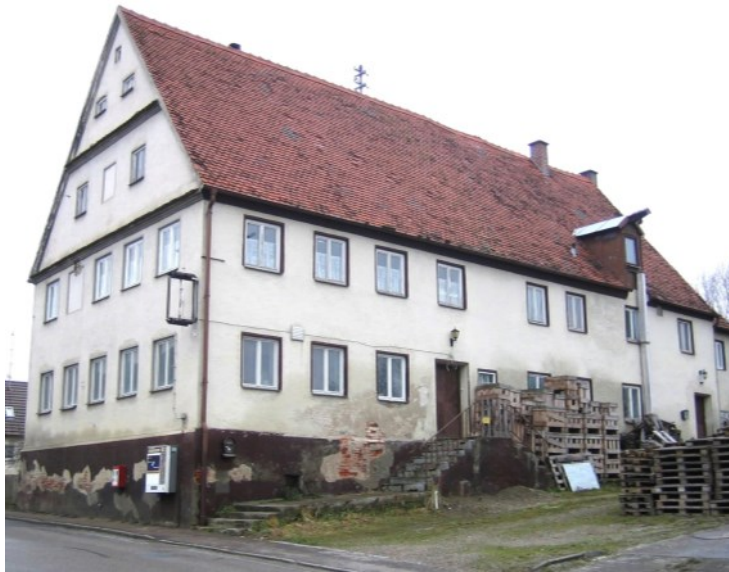
© (BLfD) Vielseitig nutzbarer Satteldachbau
